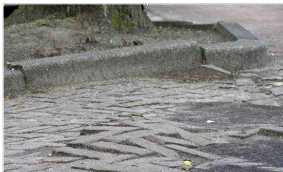
Wortelopdruk als gevolg van gebrek aan goede ondergrondse groeiruimte
