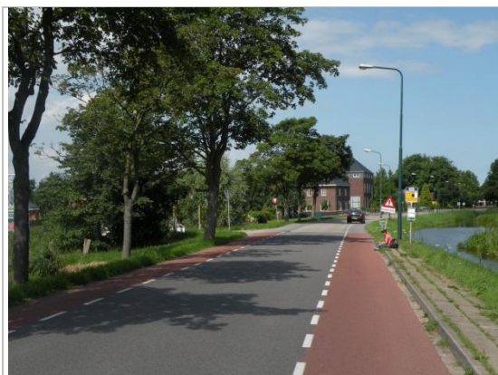
Geen herkenbare entree zuidzijde.
