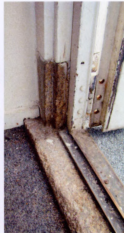
Detail van de verzorgde overgang tussen deurkozijn en stenen plint in gebouw A
