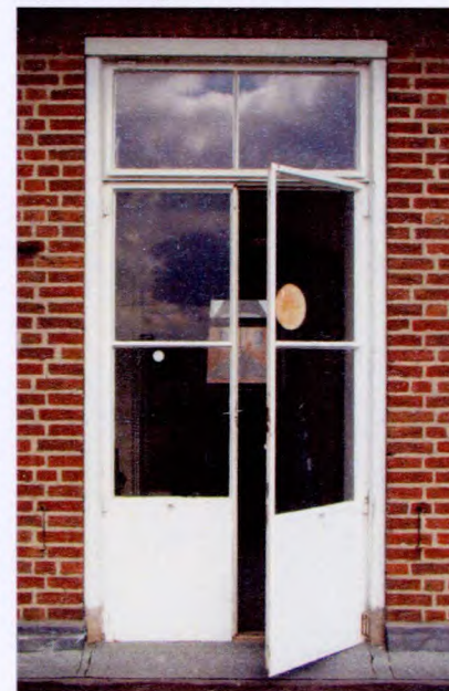
Balkondeur op +3 van gebouw A
