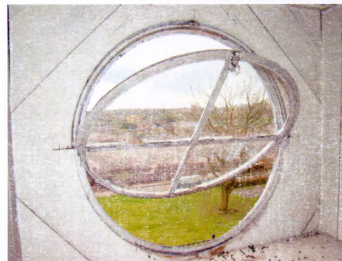
Zolderraam in gebouw A
