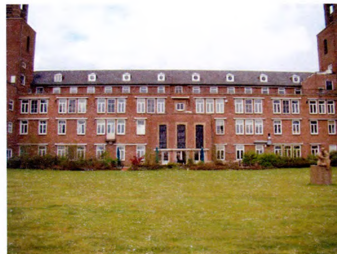
Zuidgevel van gebouw A, enkel de ramen met smalle profielen zijn nog origineel
