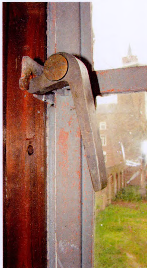
Sluitwerk van een zolderraam in gebouw F
