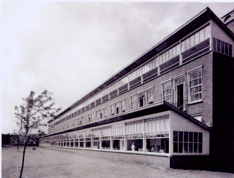
Historische foto van gebouw D waarop duidelijk de openschuivende ramen te zien zijn op de gelijkvloerse en tweede verdieping. Alle ramen in deze gevel zijn vervangen (documentatie architectenbureau).
