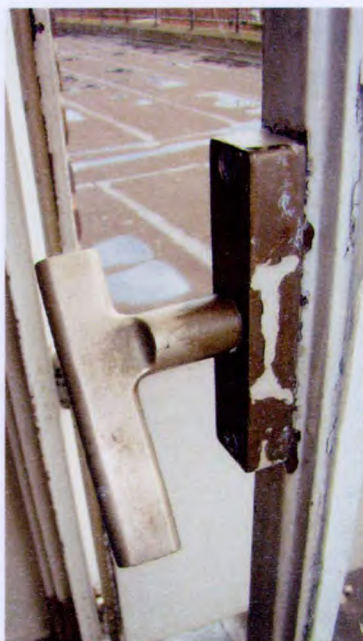
Deurkruk van de balkon- deur in gebouw A
