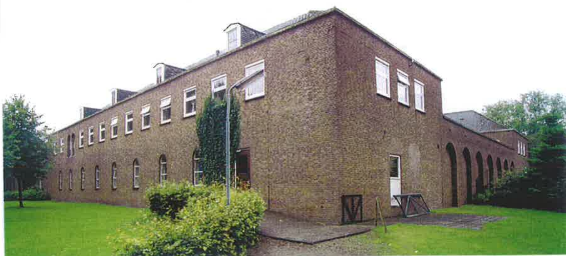
Afb. 50 (boven) Overzicht van de oostgevel van het westelijke carré-vormige gebouw, het voormalige zusterhuis. De bakstenen oostgevel is voorzien van een arcade met natuurstenen kolommen en een houten draagbalk. Op de hoeken van de gevel sluit een verbindingsgang aan. De eerste verdieping heeft op de zuid-oosthoek, als architectonisch element, een bifora. Dit tweelicht venster is voorzien van een natuurstenen deelzuil.
