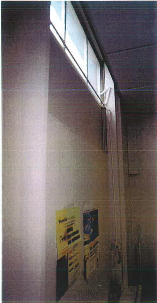
Afb. 44 (links) Restant van een oorspronkelijk venster tussen de verpleegzalen en de beddenhallen op de tweede verdieping van het hoofdgebouw. Het bovenste deel van het stalen raam, boven de betonnen luifel van de beddenhal, is nog aanwezig. Dit raam is uitgevoerd als een klampaam. Het onderste deel van het venster is thans dichtgezet, maar was oorspronkelijk een schuifraam. De kettingen waaraan het raam hing zijn nog aanwezig. Mogelijk bevindt zich achter de beplating het oorspronkelijke raam.
