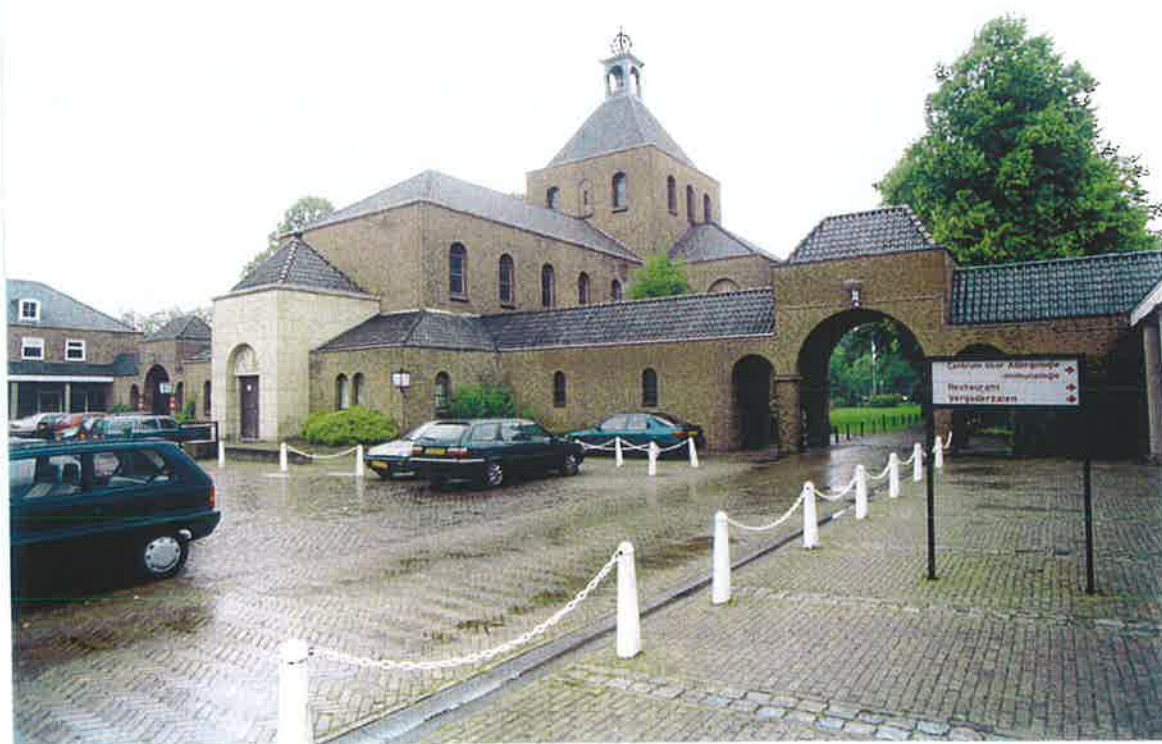
Afb. 57 Overzicht in noordelijke richting van de kapel. Deze kapel is ontworpen in een basilikale neo-romaanse opzet met transeptarmen, twee zijkapellen, een absis en een vieringtoren. Het bakstenen gebouw is aan de buitenzijde sober gedetailleerd.
