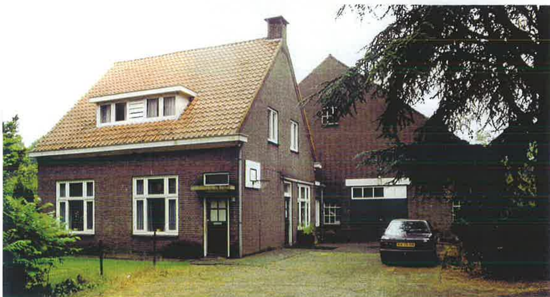
Afb. 71 (boven) Overzicht van de noord-westhoek van het transformatorhuis. Dit vrijstaande gebouw bestaat uit een rechthoekige massa met schilddak. De gevels van het transformatorhuis zijn sobere bakstenen gevels met in de noord-, oost- en westgevel een toegang. Boven de toegang in de noordgevel is een ronde ventilatie-opening. De openingen in de oost- en westgevel hebben een bakstenen stoep. Alle gevels zijn voorzien van vierkante ventilatie-openingen langs de boven- en onderzijde. De kunststenen dakrand vormt tevens de goot.
