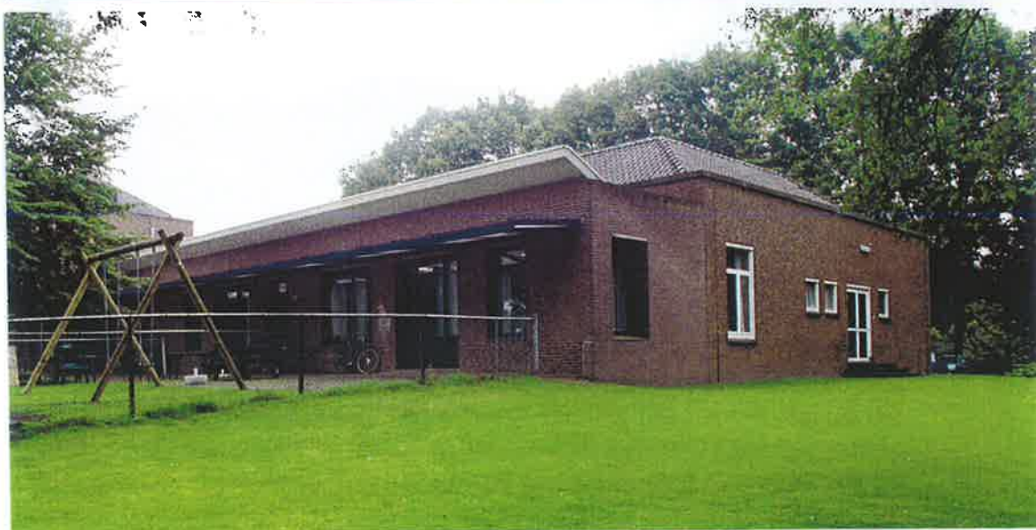
Afb. 34 (boven) Overzicht van de noordgevel van de oostelijke verplegingsvleugel. De noordgevels van de verplegingsvleugels zijn verlevendigd met uitspringende gebogen muurvlakken met daarin glas-in-lood.
