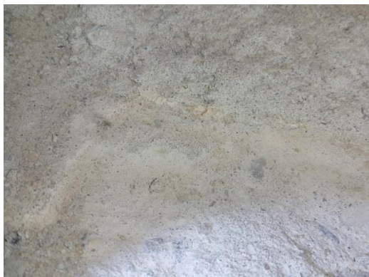
Fb02: Impressie destructief onderzoek onder vaste vloerafwerkingen.
