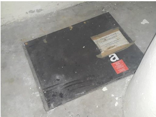
Fb02: In de kruipruimte is een historische verontreiniging aanwezig, de kruipruimte valt buiten de scope van onderhavig onderzoek.
