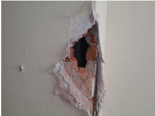
Fb05: Impressie destructief onderzoek in schachten.
