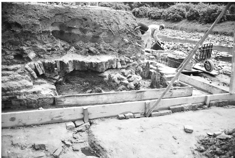
Afb. 4.31 Opgraving door de toenmalige ROB Slot Zuilen, 1981 (foto toenmalige ROB)
