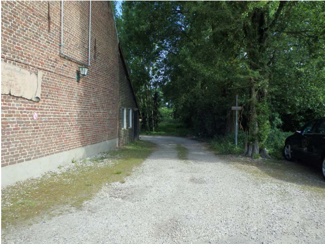
foto 1: puinhoudende verharding ten oosten van pand (gezien vanuit het zuiden, 22 mei 2015)
