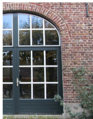
Afb. 10 Detail van een van de authentieke poortopeningen met langs de opening een rij klezoren (zie afb. ... met aanduiding klezoren)
