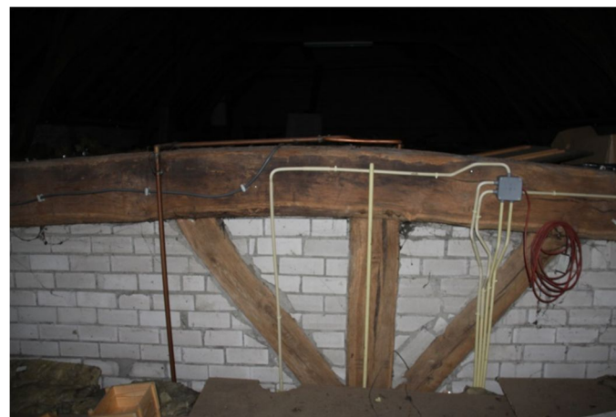
Afb. 50 De moerbalken in het centrale gedeelte zijn zichtbaar op de zolder (en tonen aan dat deze ook in eiken zijn uitgevoerd).
