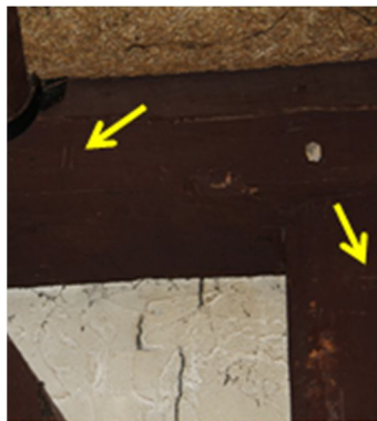
Afb. 46 Telmerken (III) op de moerbalk en staander in de westelijke ruimte (2 e spant).
