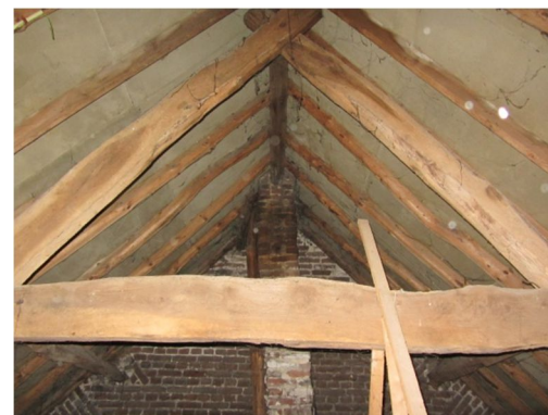
Afb. 65 Het oostelijke spant. Op de achtergrond het vlechtwerk van de kopgevel van de schuur.
