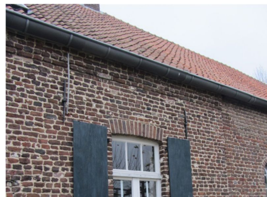
Afb. 19 Detail van de voorgevel, met onder de mastgoot ietwat uitkragend metselwerk
