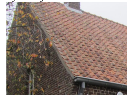
Afb. 8 Oudhollandse pannen op het dak.
