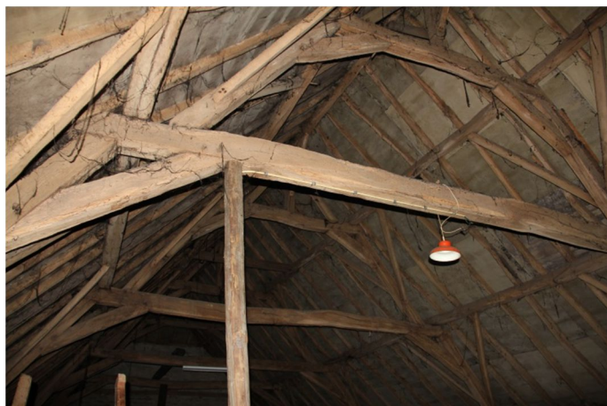
Afb. 48 De eikenhouten kapconstructie met drie gestapelde gebinten.
