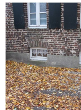
Afb. 24 Detail van de noordwestelijke kopgevel (kelderraam)
