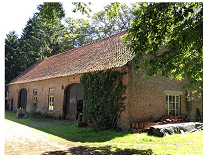
Afb. 90 Tiendschuur kasteel Aerwinkel. Ook hier zijn tussen de poorten en in de kopgevel aanvullende vensteropeningen geplaatst.
