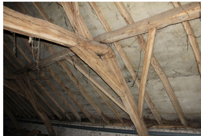
Afb. 49 Detail van één van de spanten.
