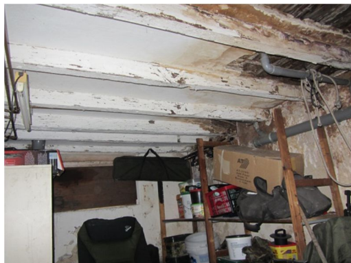
Afb. 53 De noordwestelijke kelderruimte.
