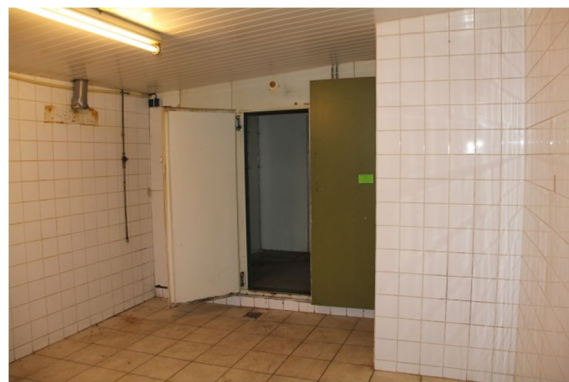
Afb. 69 Het oostelijke gedeelte van de stal, in gebruik geweest als keuken.
