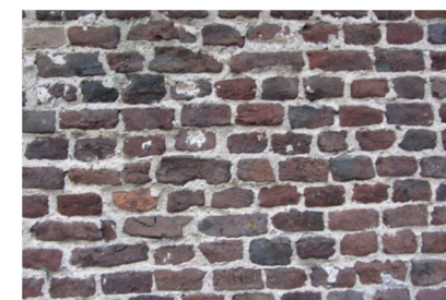
Afb. 6 Metselwerk in wildverband bij woning uit 1920.
