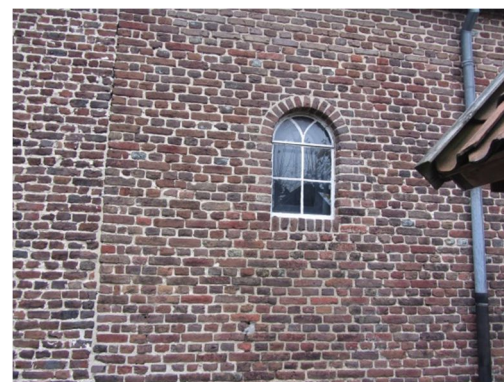
Afb. 15 Het linker geveldeel met stalen raam uit 1920 en grens naar woning uit 1920.
