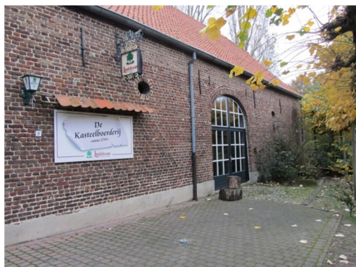
Afb. 9 Rechter gedeelte van de voorgevel van de schuur.
