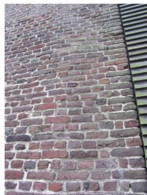
Afb. 26 Detail van de rechter hoek, met klezoren en snijvoegen.
