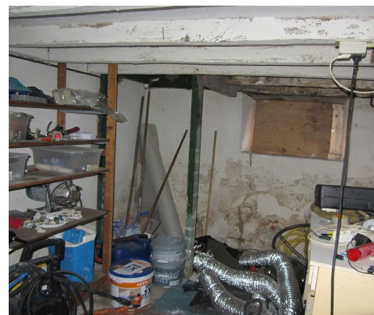
Afb. 52 De zuidwestelijke kelderruimte met linksboven de raveling die kan duiden op een oorspronkelijke trapopgang.
