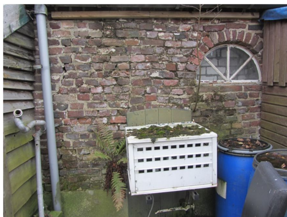
Afb. 34 Het linker deel van de achtergevel
