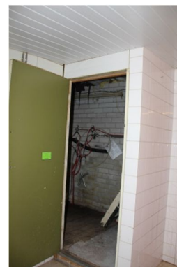
Afb. 70 Portaal met opgang naar de zolder.
