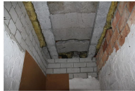
Afb. 45 Plafond (betonnen elementen) in het centrale gedeelte.
