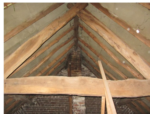
Afb. 23 Kopgevel van de voormalige tiendschuur, met vlechtwerk (zichtbaar op zolder woning).
