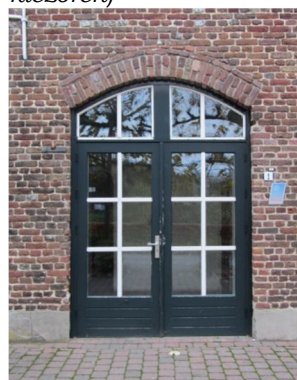
Afb. 12 De in 1980 aangebrachte gevelopening.
