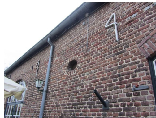
Afb. 13 Detail van de gevel met uilengat en jaarankers.
