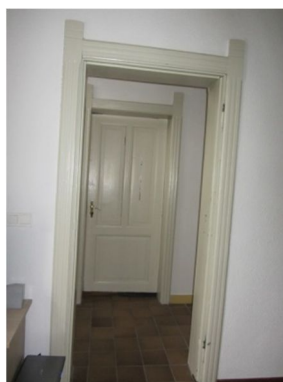
Afb. 57 Authentieke kozijnen en deuren
