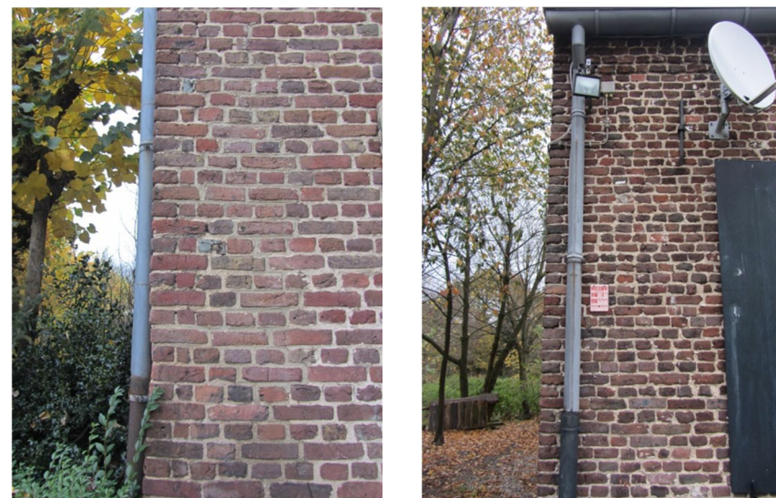
Afb. 103 verschil in metselwerk tussen de schuur (links: kruisverband, klezoren op hoek, snijvoeg met rode kleur) en de woning (rechts: rommelig wildverband, op meerdere plekken geen verband maar rijen koppen recht boven elkaar, platvol gevoegd).
