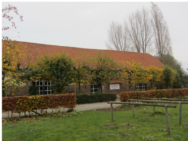
Afb. 75 De bomen en haag die vóór de voorgevel van de schuur staan, blokkeren (visueel en fysiek) de oorspronkelijke toegangen tot de schuur.
