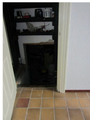
Afb. 54 De toegang tot de kelder met aan de onderzijde van de trap een later aangebrachte doorgang.
