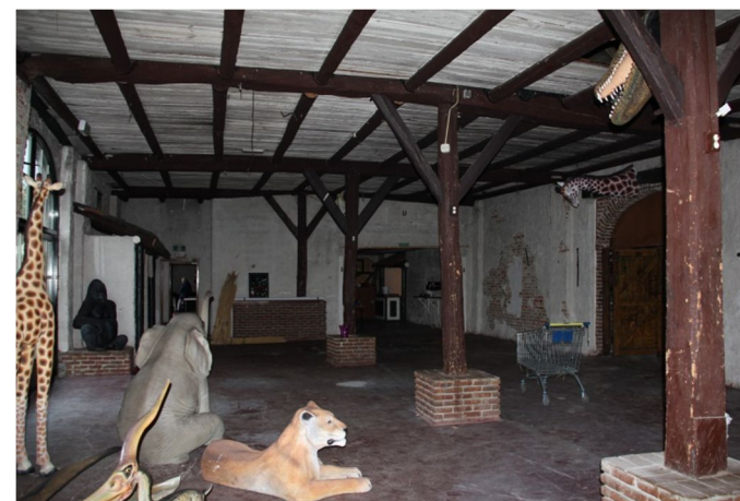
Afb. 39 Het oostelijke gedeelte van de schuur, in westelijke richting.
