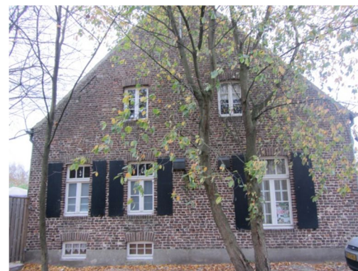
Afb. 21 De noordwestelijke kopgevel
