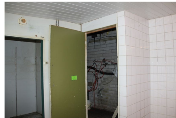
Afb. 30 De nieuw opgetrokken muren (ietwat meer naar zuiden) ter plekke van de in 1980 gemaakte doorbraken in de achtergevel.
