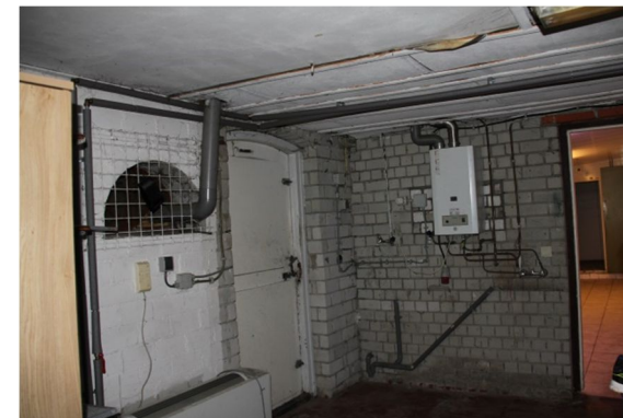
Afb. 71 Centrale ruimte in de stal, met het enige stalvenster dat inzichtelijk is gebleven (dichtgetimmerd en voorzien van doorvoer).
