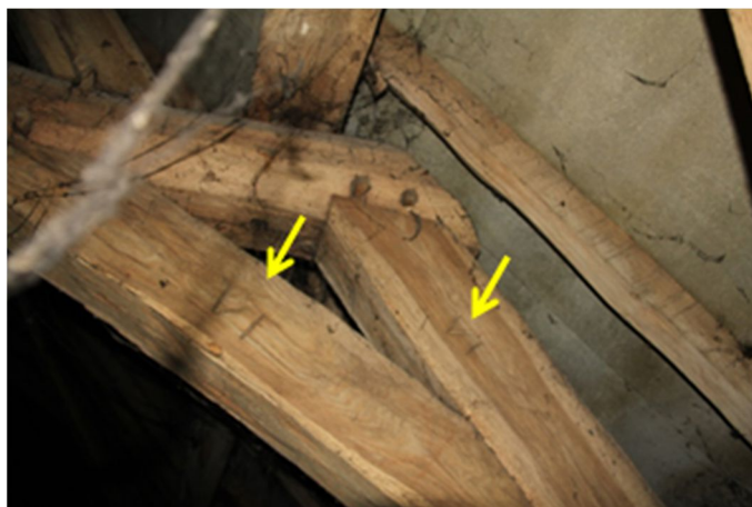
Afb. 51 Detail van een van de spanten met telmerken (VI)
