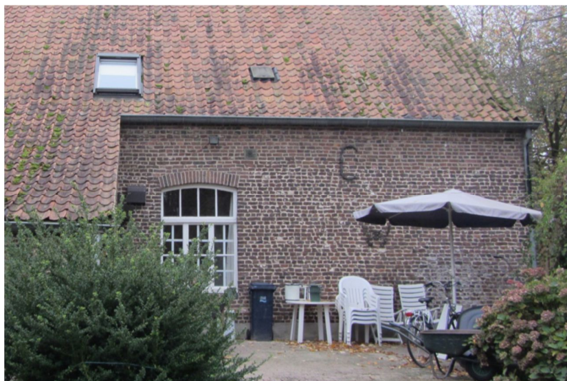
Afb. 31 De achtergevel van het woonhuis.
