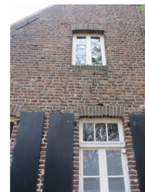
Afb. 22 Detail van de noordwestelijke kopgevel
