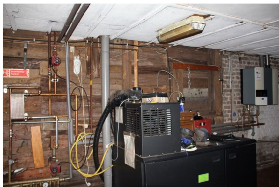
Afb. 29 Het rechter gedeelte van de achtergevel met achter het hout de voormalige poortdoorgang en rechts het authentieke metselwerk in kruisverband.
