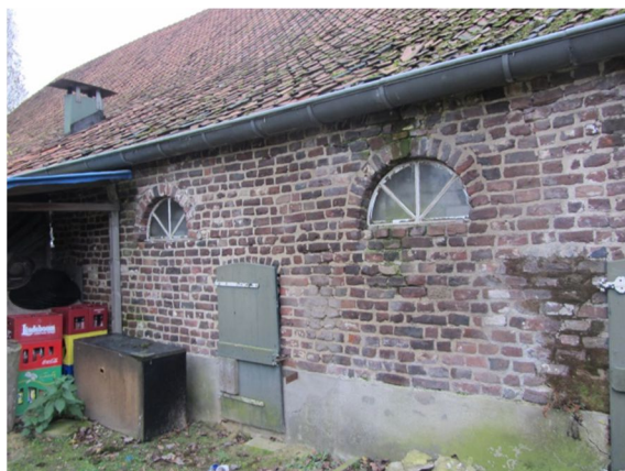
Afb. 33 Het centrale deel van de achtergevel. De ramen en deurtjes zijn van binnenuit dichtgezet.
