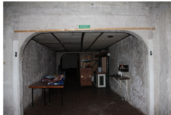
Afb. 43 Het noordelijke gedeelte van de in 1980 ingebouwde ruimte
