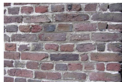
Afb. 5 Metselwerk tiendschuur in kruisverband en met snijvoeg.
