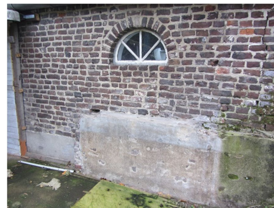
Afb. 35 Het rechterdeel van de achtergevel van de stal.
