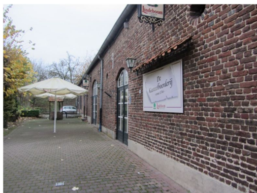
Afb. 11 Centrale gedeelte van de voorgevel van de schuur.
