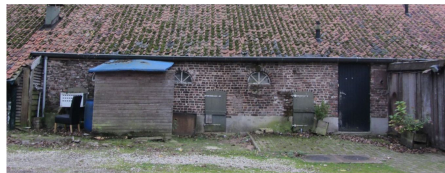
Afb. 32 De achtergevel van de stal.
