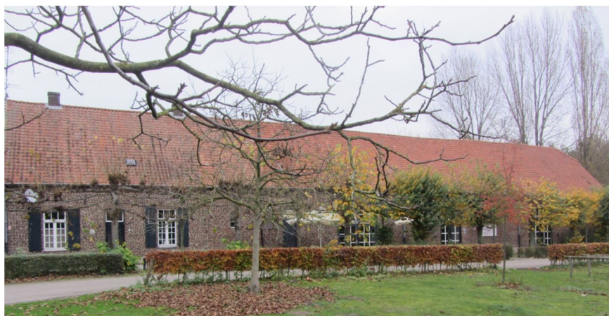
Afb. 87 Kasteellaan 1 te Horst, de tiendschuur.
