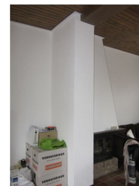
Afb. 61 Latei ter plekke van de voormalige scheidingswand tussen de woonkamers.
