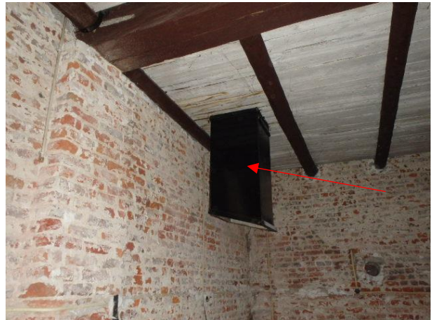
impressie schoorsteen in ruimte 0.14
