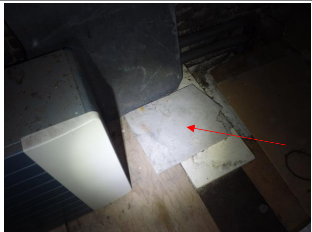
impressie losse plaat
