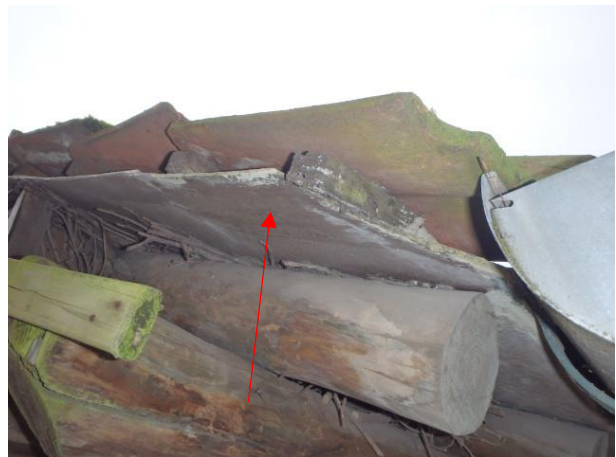
dakbeschot ook aanwezig onder dak lage aanbouw achterzijde
