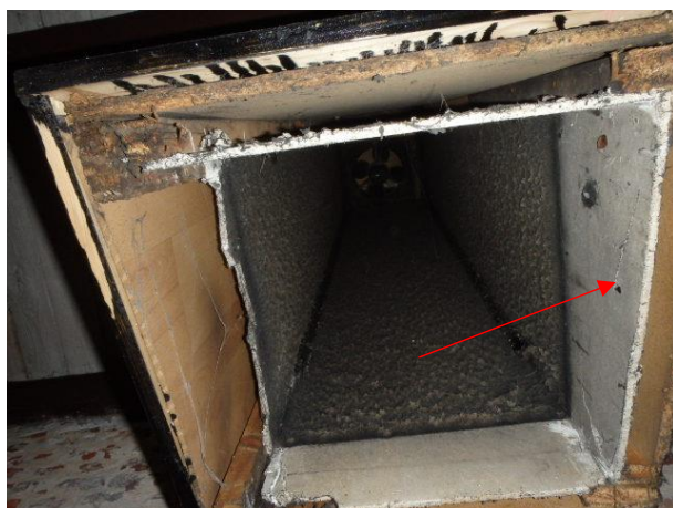
schoorsteen inwendig (gezien vanuit ruimte 0.14)
