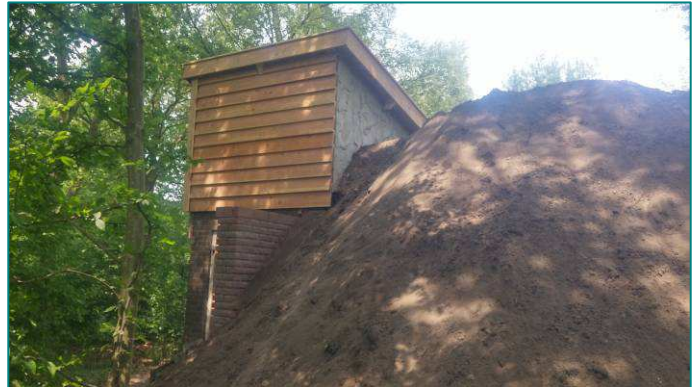
Vleermuistoren met het geheel met grond afgedekt winterverblijf.
