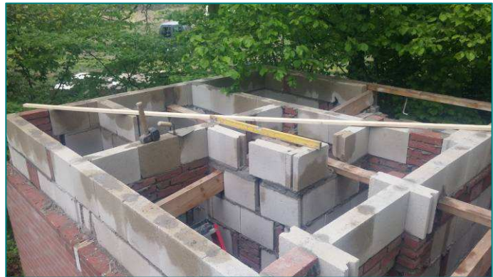
Indruk van het slakkenhuis in aanbouw binnen het winterverblijfgedeelte.
