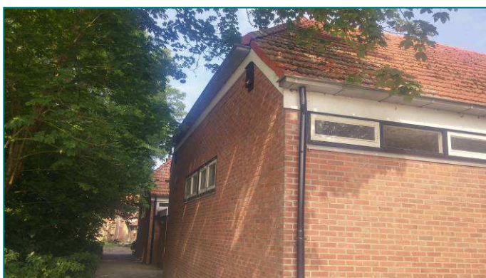
Een van de vier aangebrachte vleermuiskasten aan het te behouden gebouw.
