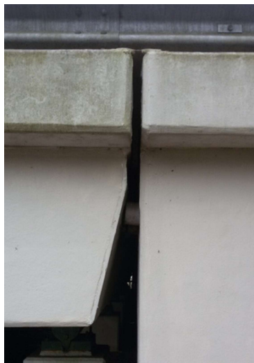
Figuur 4: In de dilatatievoegen van de viaducten onder de zuidelijke rondweg kunnen verblijfplaatsen van vleermuizen aanwezig zijn.
