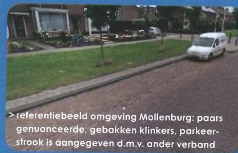
> strekse lagen in een accentkleur laten het onderscheid tussen de verschillende functies in het profiel zien
