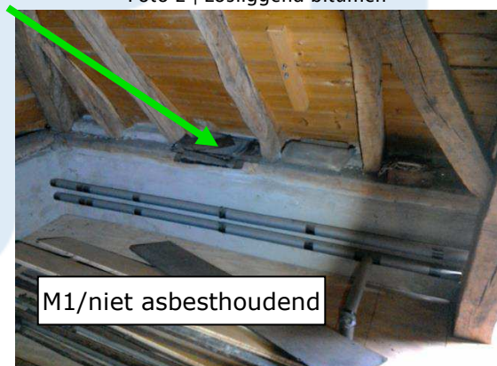
Foto 4 | Losliggend bitumen
