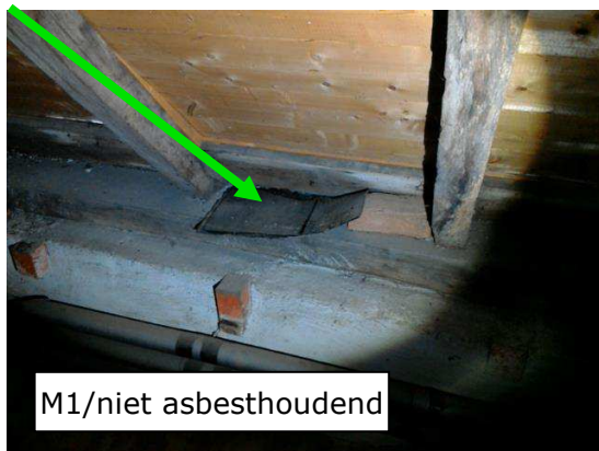
Foto 1 | Losliggend bitumen
