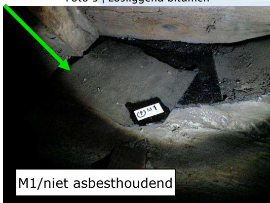
Foto 5 | Losliggend bitumen
