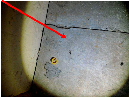
Foto 11 | Beplating op vloer cv-ruimte
