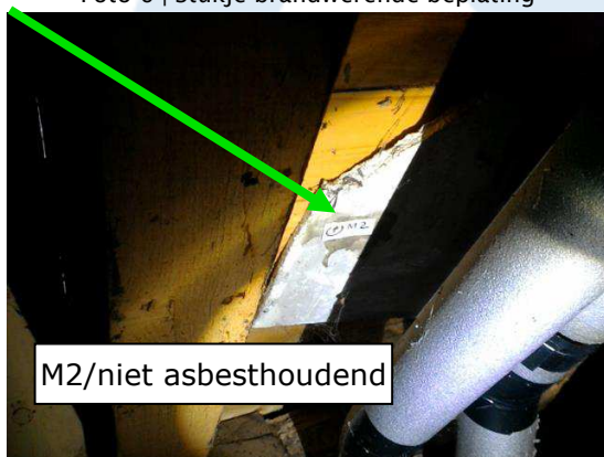
Foto 8 | Stukje brandwerende beplating
