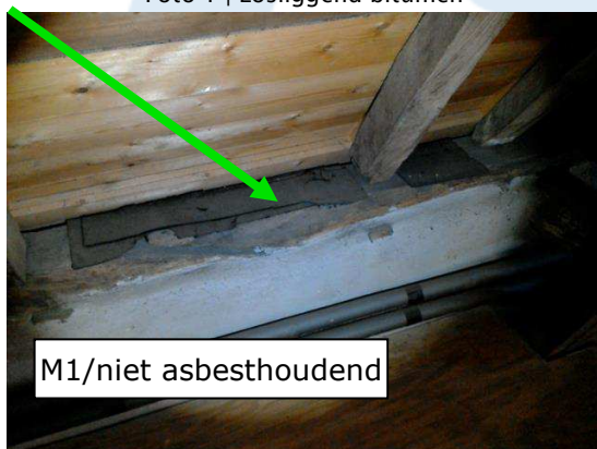
Foto 3 | Losliggend bitumen
