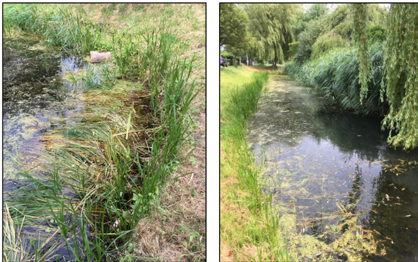
Fig. 6.15: verstikking door maaisel in het water.
