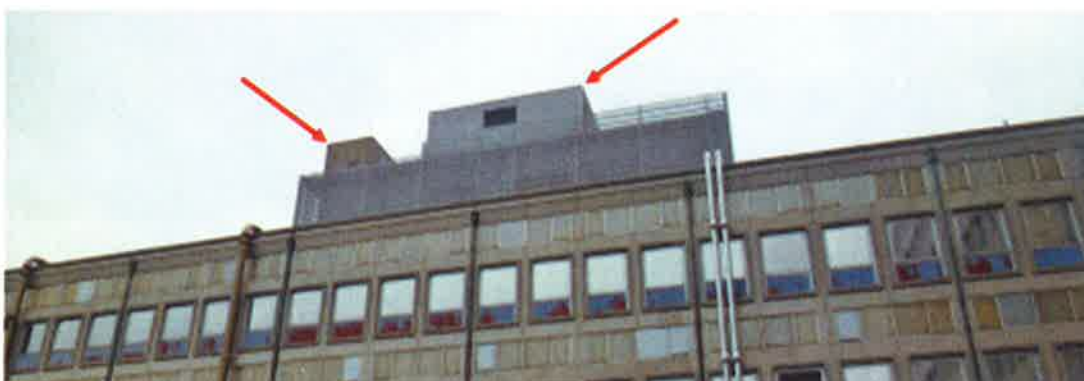
De twee opbouwjes op gebouw D, aangeduid met rode pijlen. Op de voorgrond gebouw C
