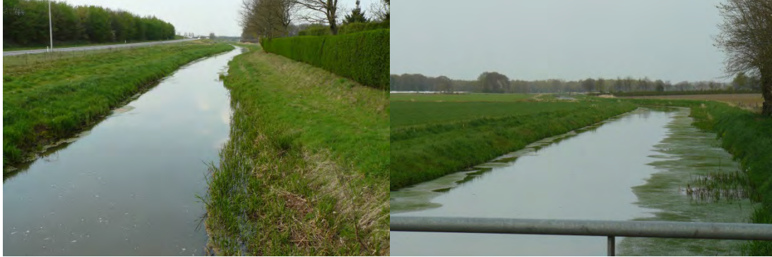
Figuur 2.6 Huidige inrichting Groote Molenbeek bovenstrooms (langs A73) (links) en nabij Kreuzelweg (rechts)
