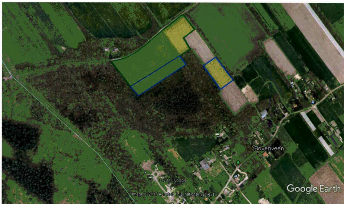
Zoekgebied aanplant 1,22 ha bos (groen omrand, grotendeels buiten Natura 2000) en twee percelen met herplantplicht (blauw omrand, binnen Natura 2000)
