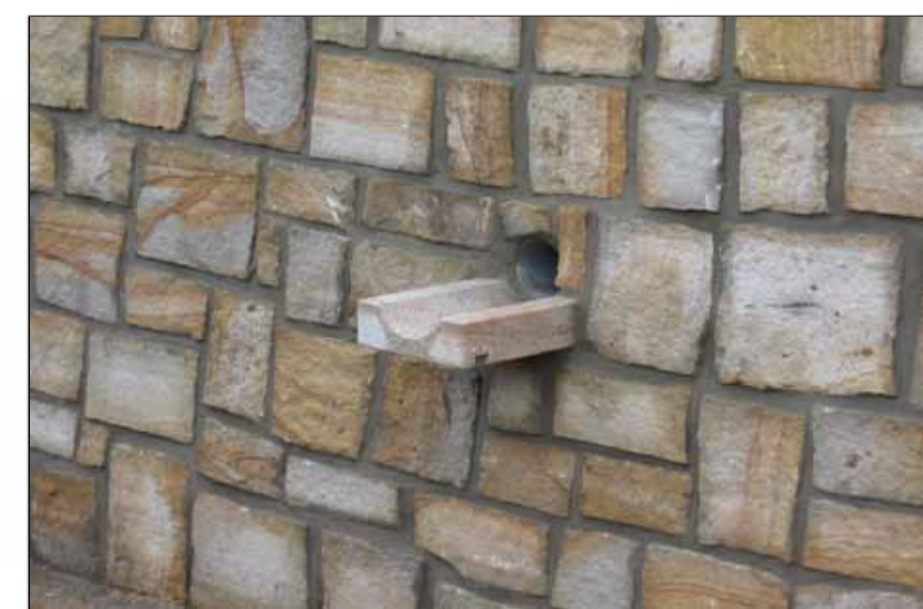
Leksteen in kademuur
