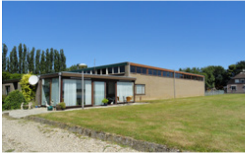
Zicht op bestaande gebouw van 32a.
