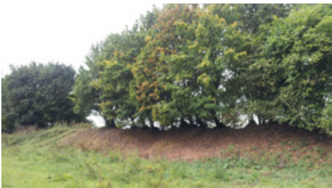
De kades rondom de vluchtplaats worden hersteld.
