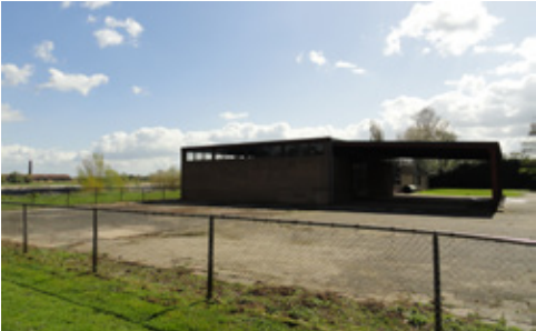
Zicht op bestaande gebouw van 32a.
