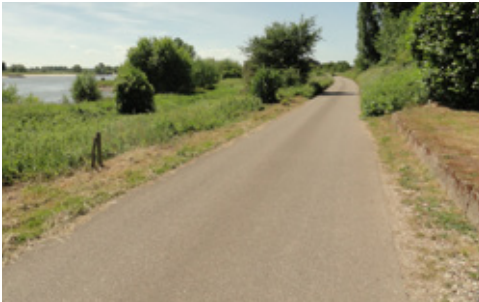
Thv Polder 32a wordt de weg verwijderd.
