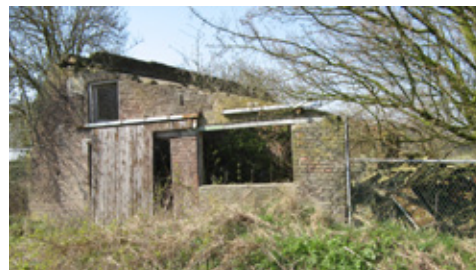
Restanten baksteenindustrie op Gannita-circuit worden gesloopt.
