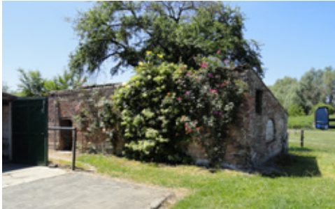
Op de fundamente van oude wijnkelder staat nu een schuur.
