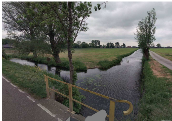
Figuur 10: Foto open zijtak in de Oude Rijndijk
