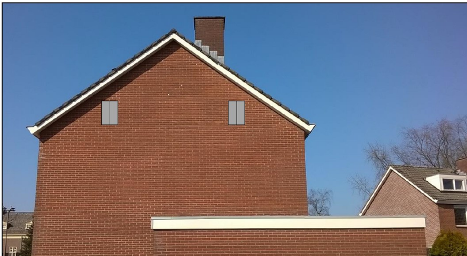
Permanente mitigatie woning Treubstraat 52 met 2x2 inbouwkasten (grijs)
