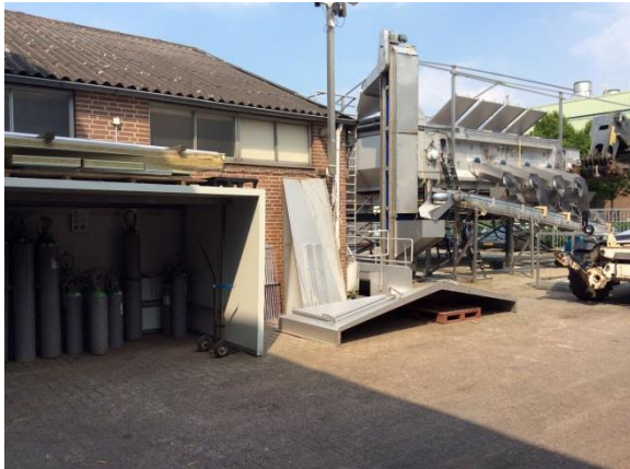
Figuur 8: Overzichtsfoto bebouwing
