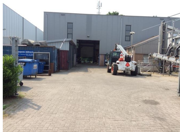
Figuur 9: Overzichtsfoto bebouwing
