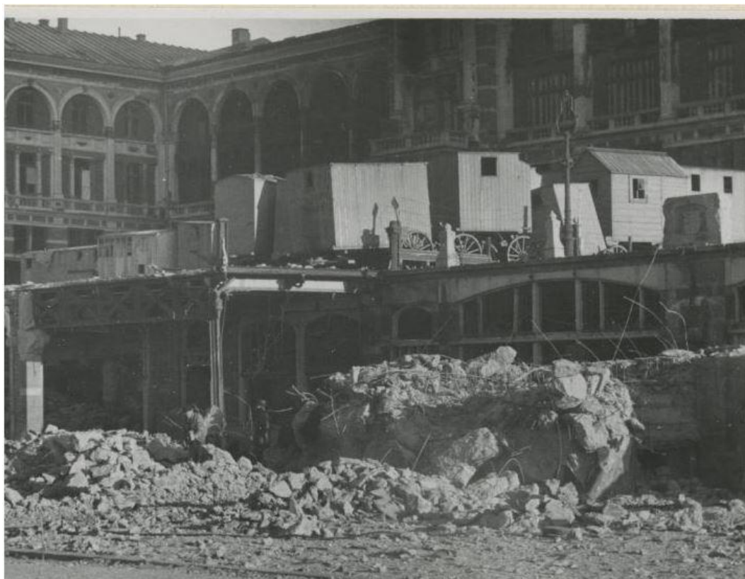
Afbeelding 18. Sloop van de tankmuur voor het Kurhaus (bron: beeldbank Haag Gemeentemuseum).
