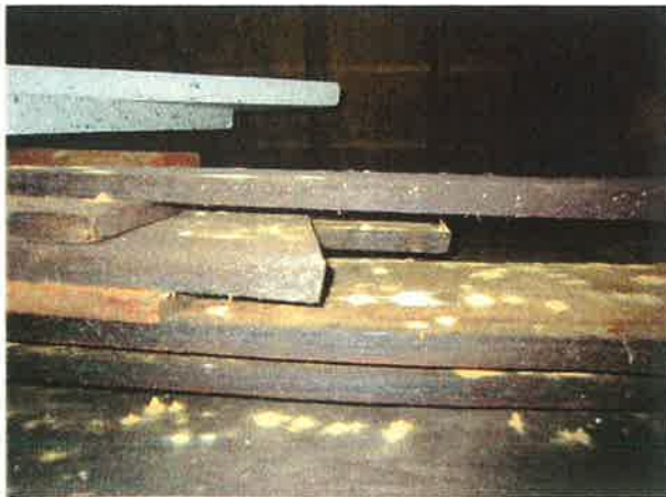
houten delen beschieting zolder westzijde schuur
