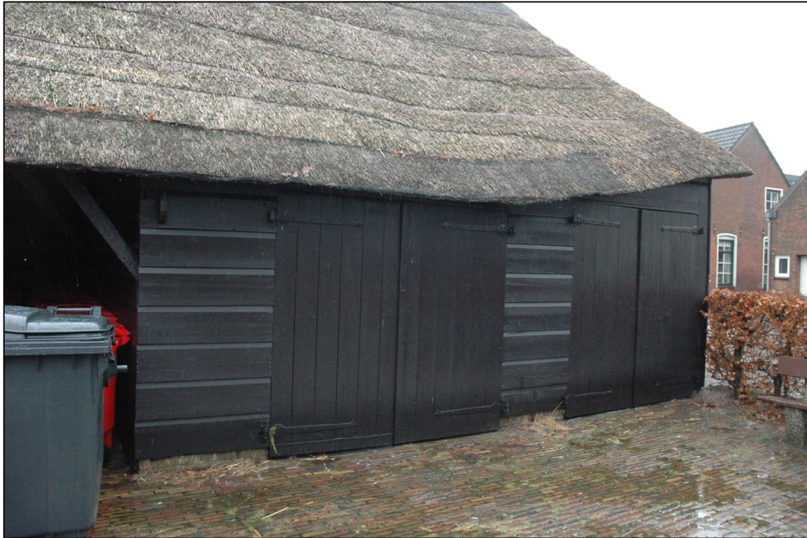
Afb. 5: Het rechtse gedeelte voor de karren, waartoe ook twee deuren werden aangebracht. De gemetselde plint is nog net zichtbaar, zoals bij de overige gevels.
