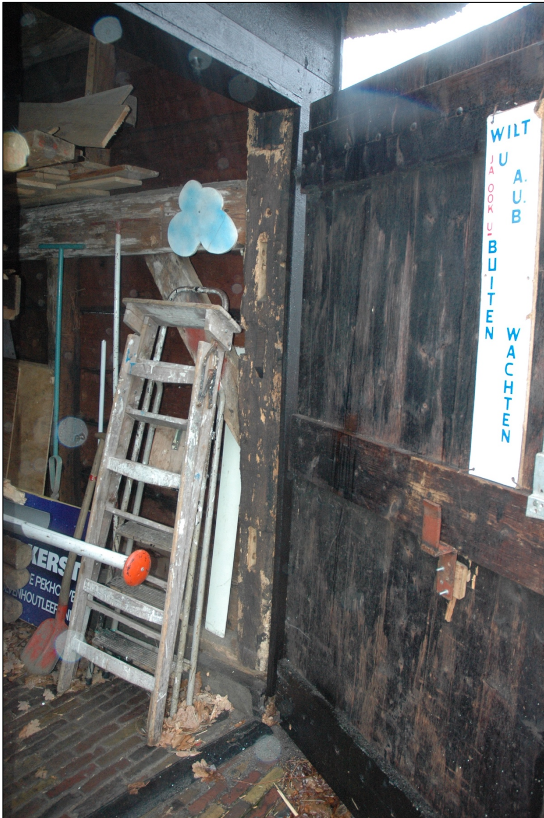
Afb. 9: De gebintstijl rechts vooraan bevat twee pengaten die duidelijk maken dat er vroeger twee horizontale regels in gepend waren. Het is goed mogelijk dat deze schuur lang geleden niet op het zuiden, zoals nu, maar op het noorden opende en dat deze wand meer gesloten was.
