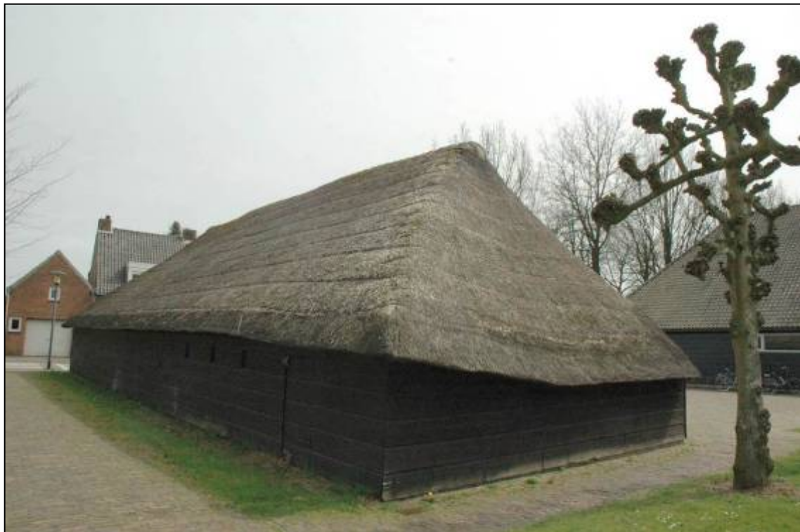
Afb. 3: De voorgevel aan de zuidkant.
