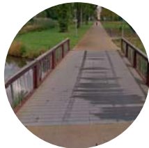
brug boven de waterinlaat
