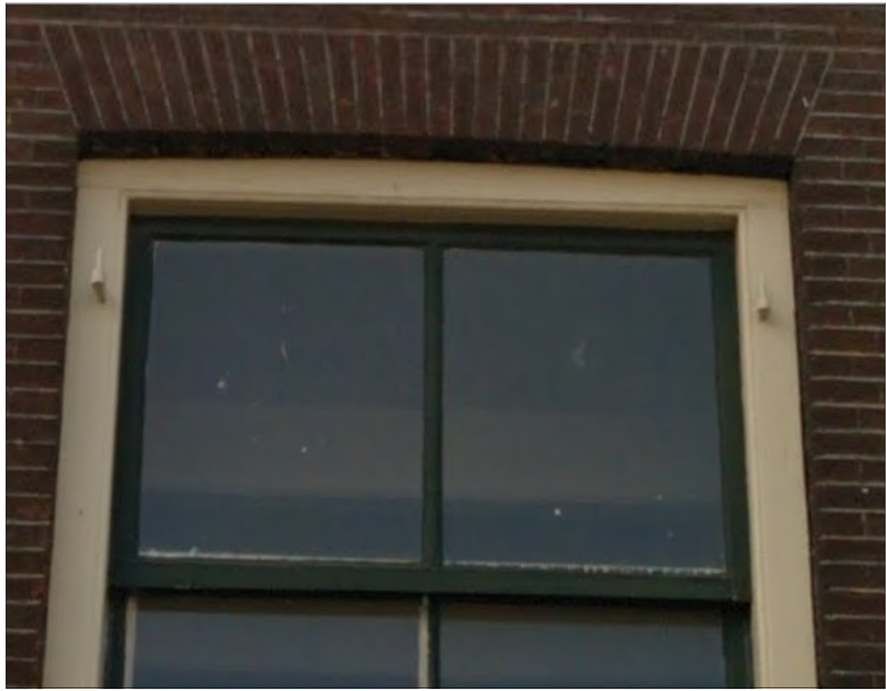
Bestaand kozijn verdieping voorgevel.
