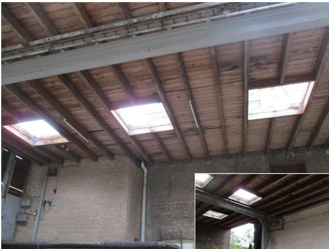
B2 onderzijde overkapping (gevel B3)
