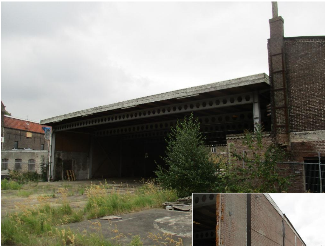
B9 Voorzijde overkapping; detail noordgevel
