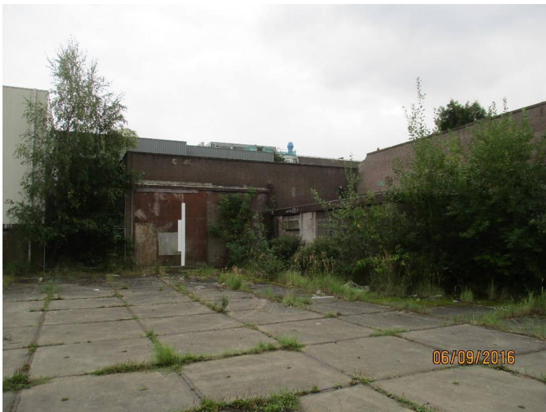
A5 bedrijfsloods, met links locatie voormalige liftschaft (boom aanwezig)
