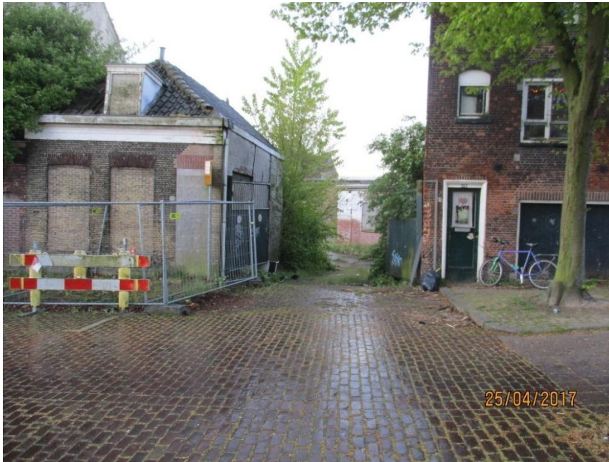
Toegang vanaf de Vetteoordsekade
