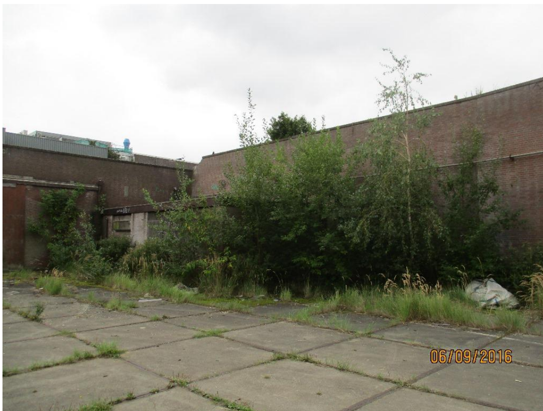
A4 Personeelsruimte (aanbouw op voorgrond)
