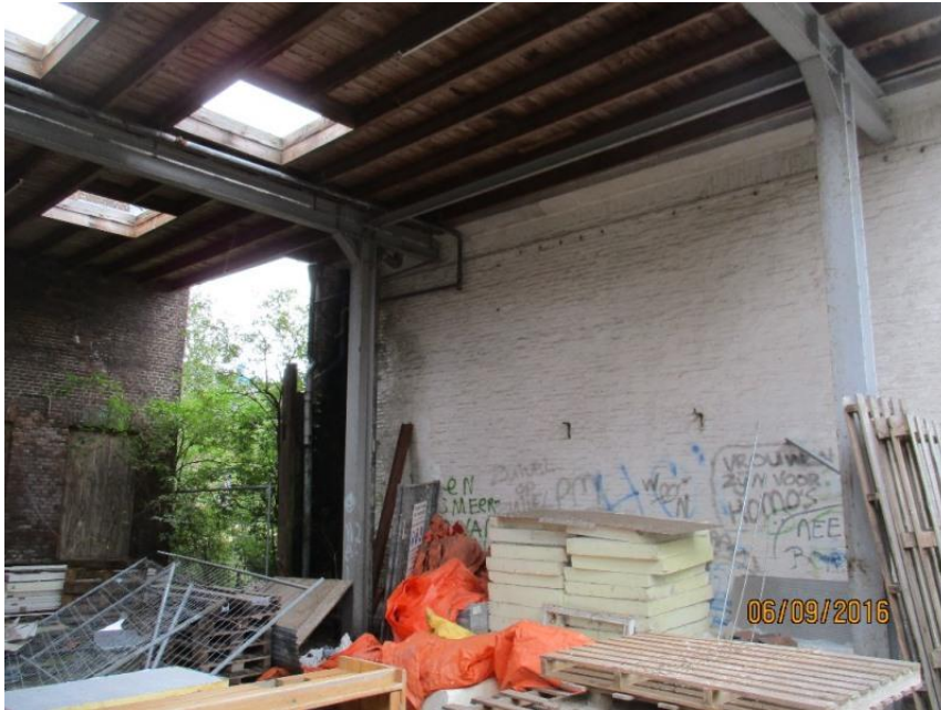
B2 aansluiting B1 (koppeling staal i.v.m. stabiliteit)
