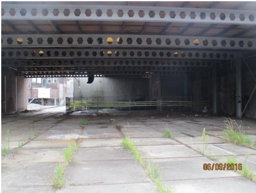
B9 beeld onder overkapping (asbest is verwijderd \ april 2016)
