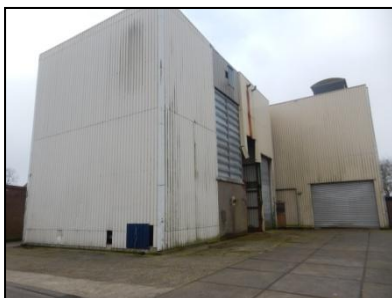
Figuur 2. Achteraanzicht bedrijfsbebouwing
