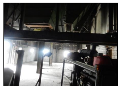
Figuur 7. Binnenzijde bedrijfsbebouwing
