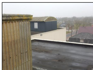
Figuur 6. Dak van de bedrijfsbebouwing.
