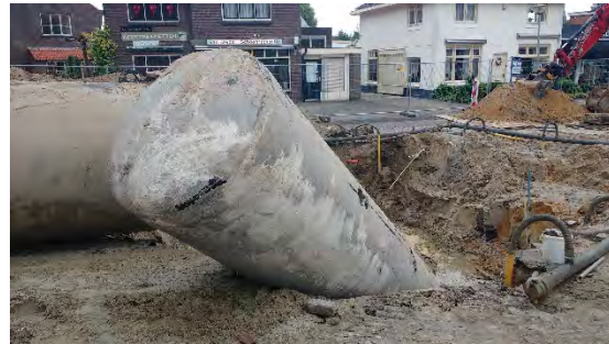
Foto 2: Lichten ondergrondse tanks
