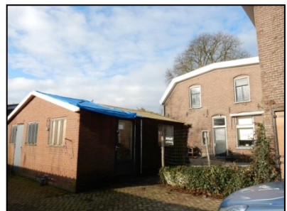
Figuur 5. Achterzijde woning.
