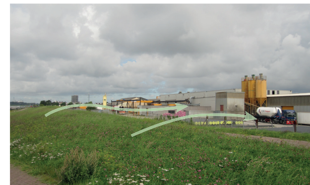
Foto bestaande situatie
