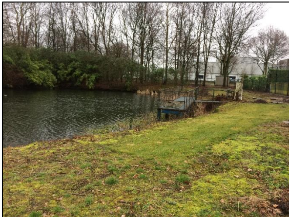
Afbeelding 4. Huidige staat infiltratievijver
