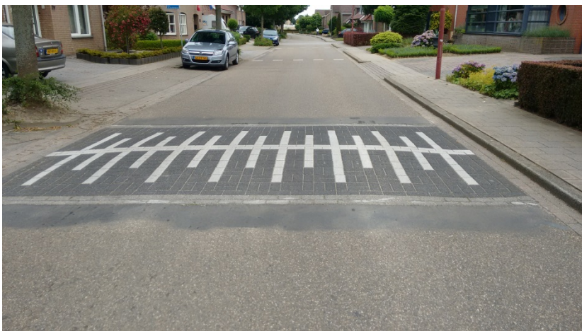
Foto: verkeersdrempel (aan de zijkanten bol gestraat zodat water er langs kan stromen)
