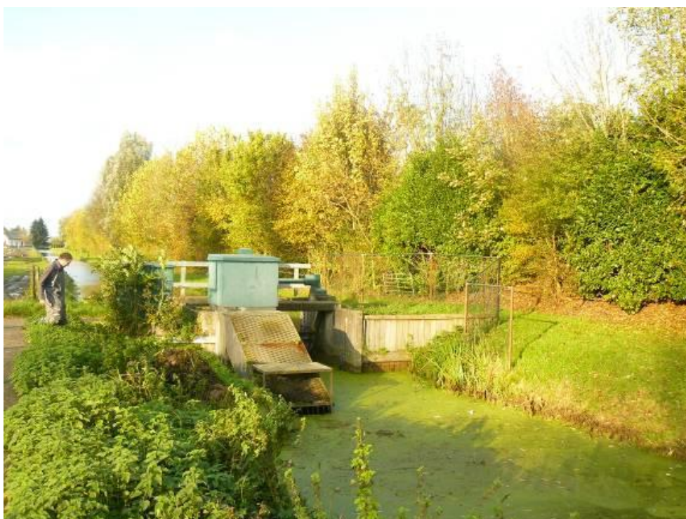
Figuur 2 Foto bestaande situatie gemaal Startstraat
