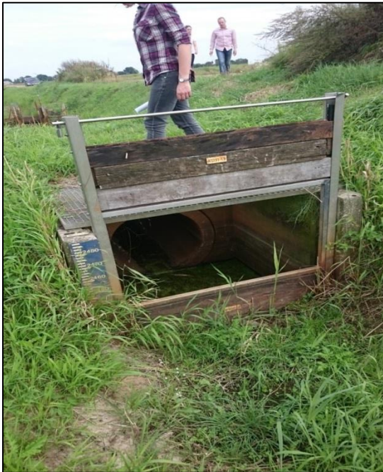
Foto 1: Stuw ST0000045 – huidige situatie.
