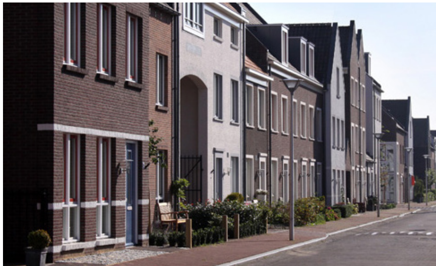
Referentie: plint met herkenbaar basement door toepassing van speklagen
