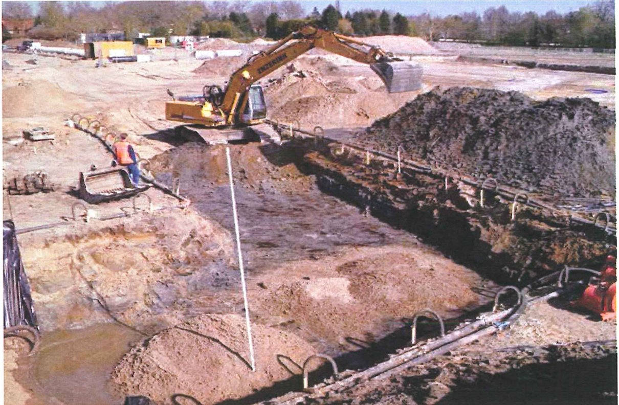
ontgraven verontreinigde grond (2)
