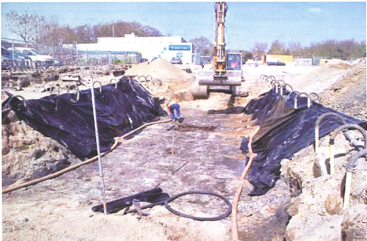
Aanvulling ontgraving en plaatsing folie + drain
