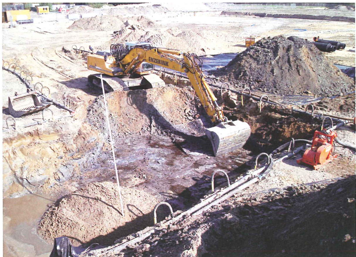
ontgraven verontreinigde grond (1)
