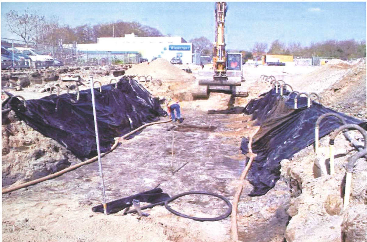
Aanvulling ontgraving en plaatsing folie + drain
