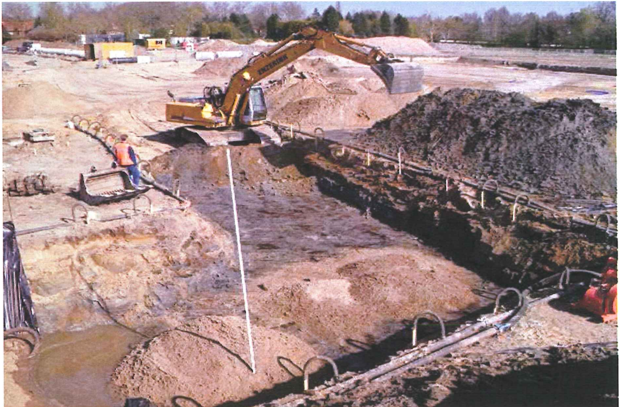
ontgraven verontreinigde grond (2)
