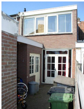
Dakopbouw door doortrekken van achteraevel bij bebouwing van één laag
