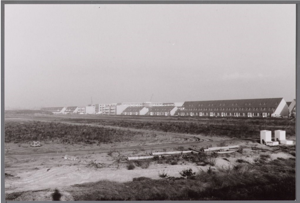
Afbeelding 9: De Purmer-Zuid in aanbouw, jaren '80
