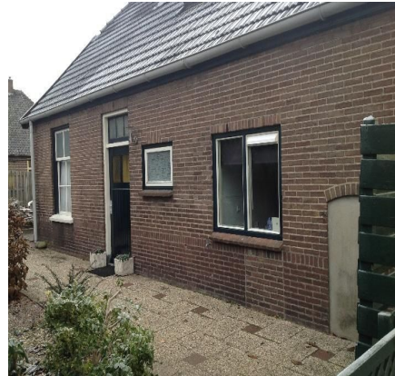
Huidige situatie rechterzijgevel
