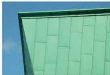
Koper vlakke stroken formaat: 200 x 800 mm dikte: 1 mm
