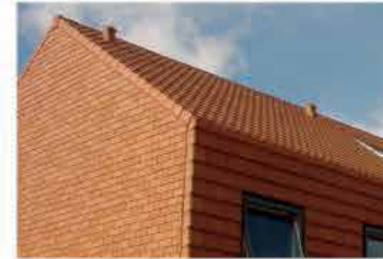
Keramische dakpannen potdeksel formaat: 400 x 250 mm
