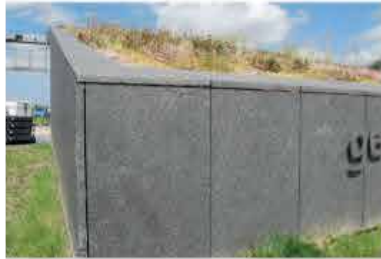
Chinees basalt vlakke platen breedte: 800 mm dikte: 30mm
