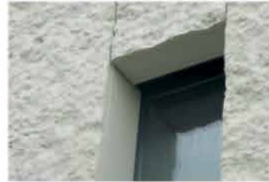
Polyesterbeton vlakke platen breedte: 800 mm dikte: 30 mm
