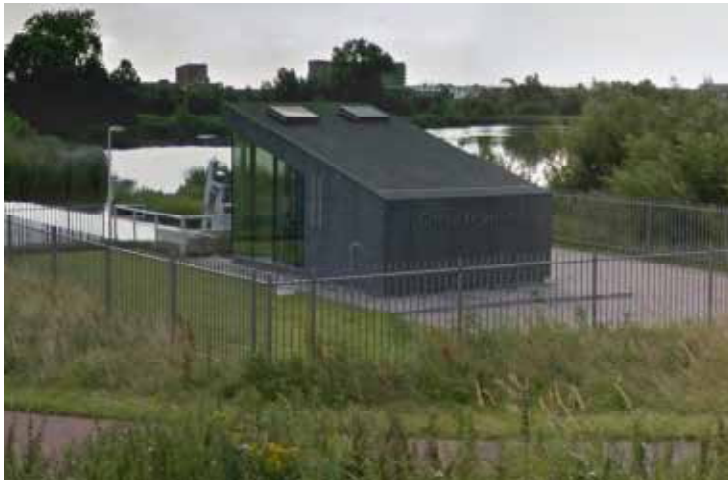
Referentie: Gemaal Keijzershof, Tuindersweg Pijnacker
