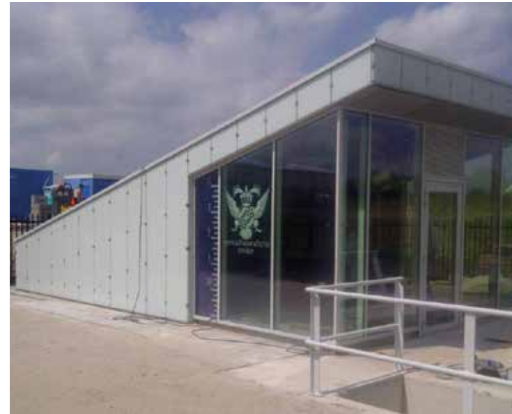
Impressie: glasplaten toegepast bij gemaal Voorafsche polder
