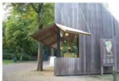
Hardhout FSC of WRC verticaal vlakke stroken breedte: 150 mm dikte: 20 mm
