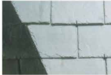
Leisteen gelaagd formaat: 350 x 250 mm dikte: 4 mm
