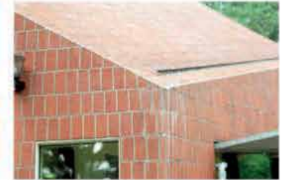
Baksteen vlak gemetseld formaat: 150 x 200 mm dikte: 50 mm
