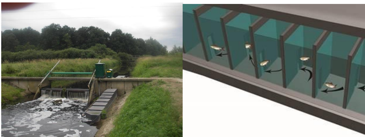
Links: referentiefoto van een De Wit vispassage langs een stuw, rechts: verspringende openingen in de vispassage
