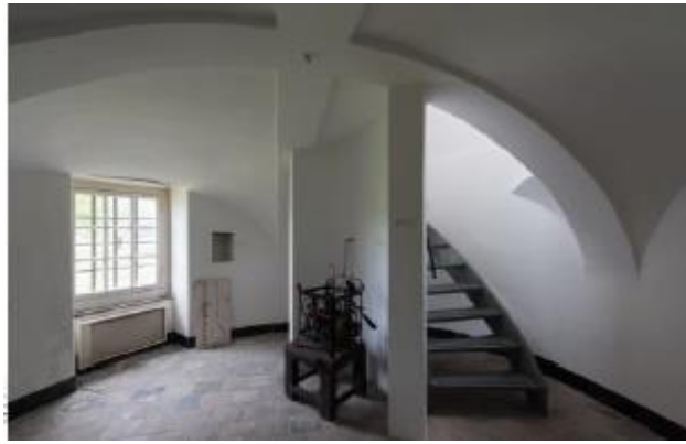
Torenruimte in het souterrain waar de nieuwe lift en trap komen. Het raam wordt door een deur vervangen
