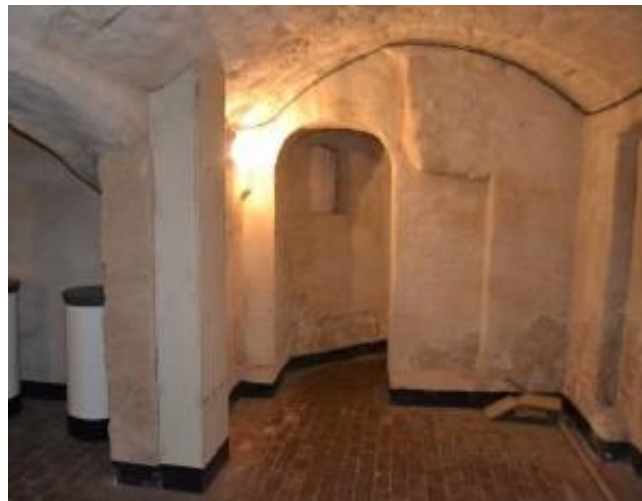
Historische muurwerk van de oudste kern van het kasteel
