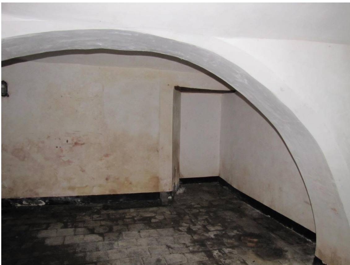
Figuur 8. ongebruikte ruimte in de kelder
