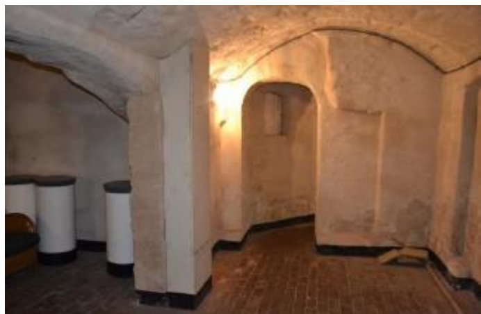
Historische muurwerk van de oudste kern van het kasteel
