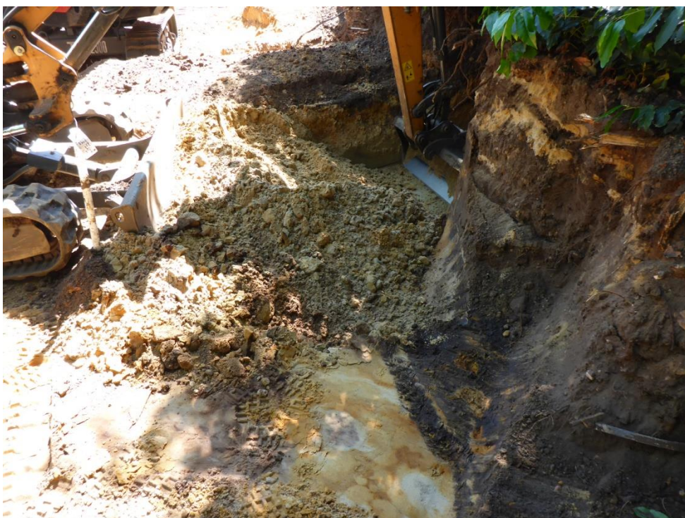
foto 32: P1050942.JPG: .... waarbij ook deel W02 (zie foto 16) verder wordt ontgraven.
