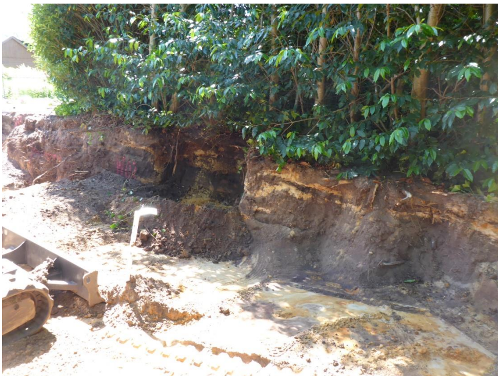
foto 31: P1050941.JPG: Verdere ontgraving ter hoogte van peilbuis 19, o.b.v. resultaten SBB01 ....
