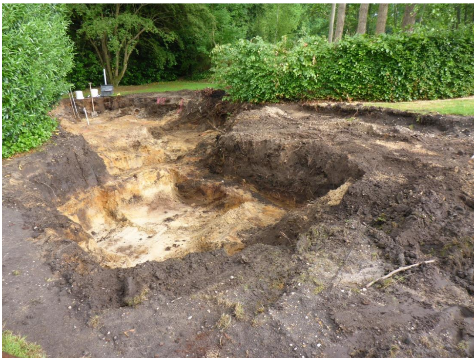
foto 19: P1050889.JPG: Tussenstand ontgraving.
