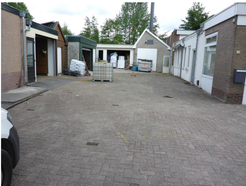
foto 15: P1060019.JPG: Klinkers verwijderd voor injectie bron 1.
