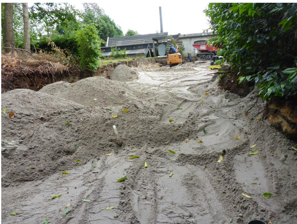
foto 42: P1050995.JPG: Aanvullen onderzijde put met aangevoerd zand.
