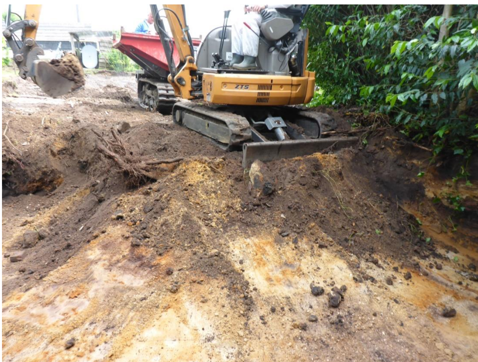
foto 15: P1050874.JPG: Start ontgraving verontreinigde laag (westzijde ontwerp ontgraving). Geen eenduidige laag met stortmateriaal .....
