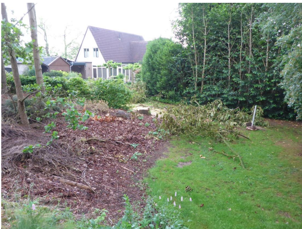
foto 4: P1050794.JPG: Overzicht voor start ontgraving.
