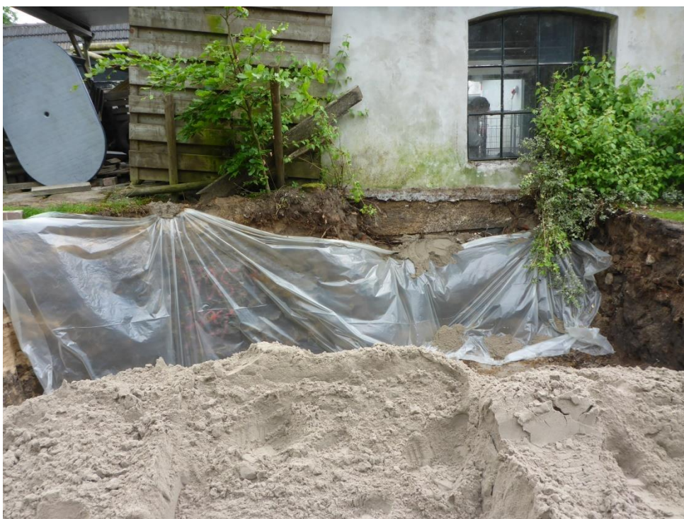
foto 43: P1050996.JPG: Bij aanvullen folielaag (signaallaag) tegen restverontreiniging in wanddeel W05H aangebracht.
