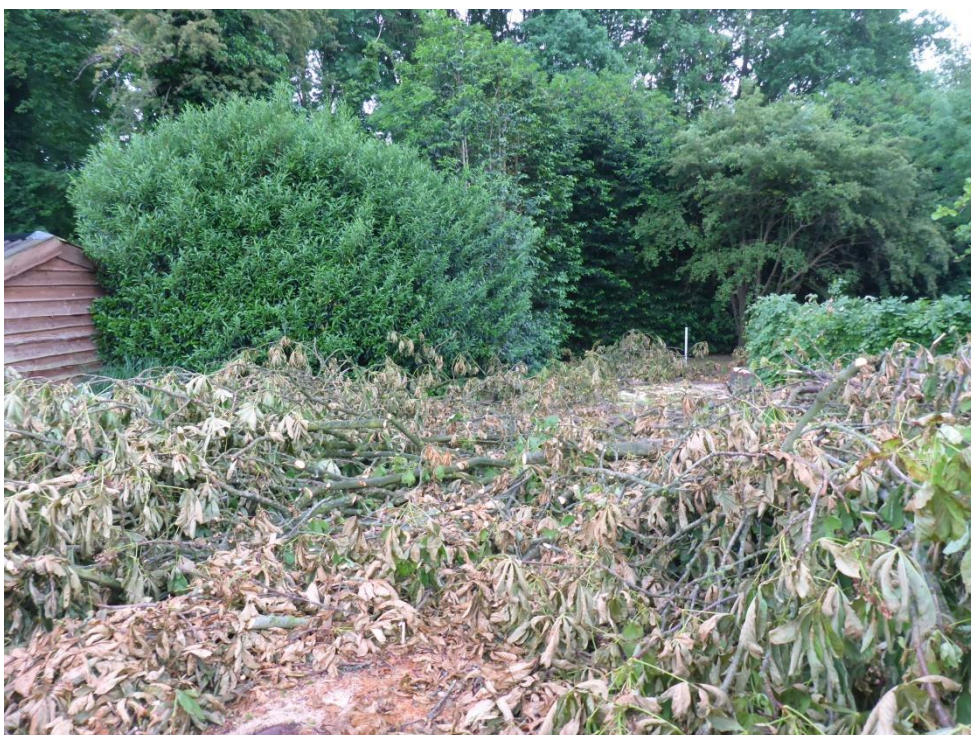
foto 3: P1050785.JPG: Overzicht voor start ontgraving.
