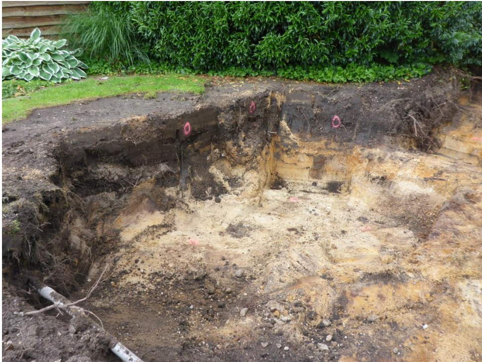
foto 25: P1050911.JPG: Tussenstand ontgraving. De 0-etjes op de putwand betreffen de totaalkoolwaterstof metingen .....
