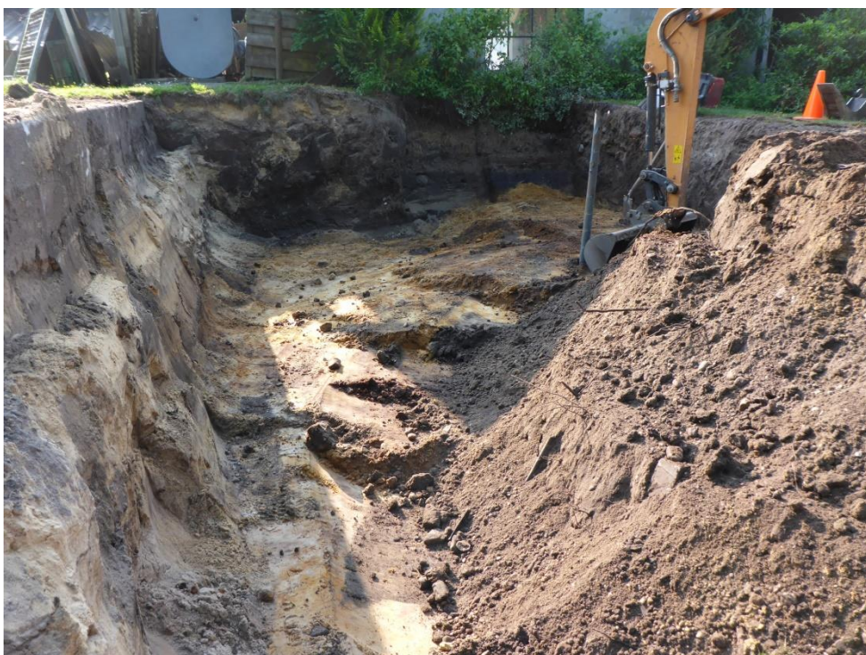
foto 37: P1050954.JPG: Tussenstand ontgraving.
