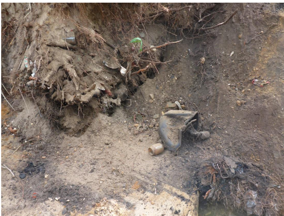
foto 22: P1050899.JPG: Voortzetting ontgraving, waarbij zeer heterogeen verdeeld stortmaterialen worden aangetroffen.
