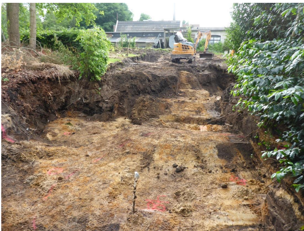
foto 20: P1050893.JPG: Tussenstand ontgraving. Peilbuis 19 blijft behouden.
