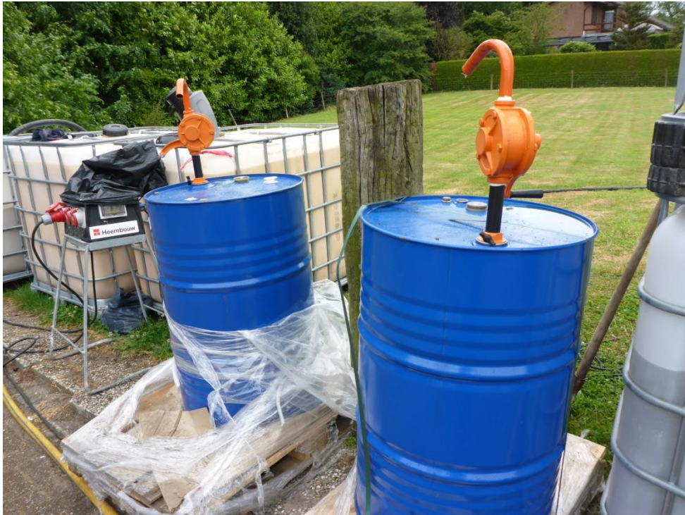
foto 7: P1050979.JPG: Voorraad voor het aanmaken van de injectievloeistof.
