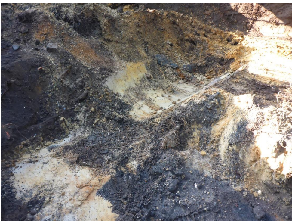
foto 18: P1050886.JPG: .... en dus dieper wordt ontgraven cq ontgraven kon worden omdat de grondwaterstand relatief laag was.
