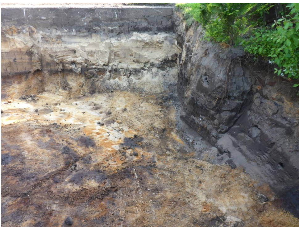
foto 36: P1050952.JPG: Eerste resultaat ontgraving oostzijde put: wanddeel W05 (rechts) en wanddeel W04 (achtergrond).
