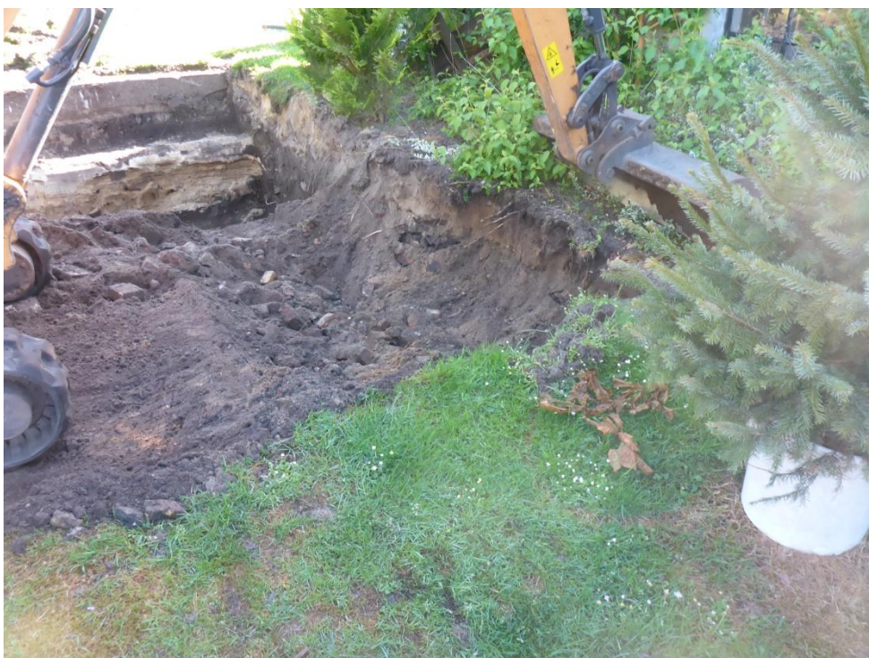
foto 28: P1050934.JPG: Ontgraving oostzijde put: wanddeel W05. Laag bakstenen aanwezig.
