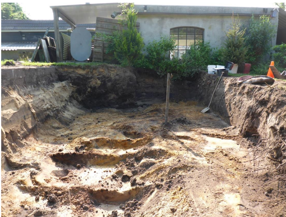
foto 38: P1050958.JPG: Tussenstand ontgraving.
