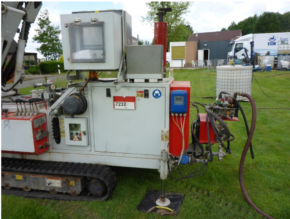
foto 11: P1050912.JPG: Uitvoering directe injectie met sonic drill t.p.v. bron 5, machine heeft eigen pomp voor aanvoer injectievloeistof vanuit buffervat.
