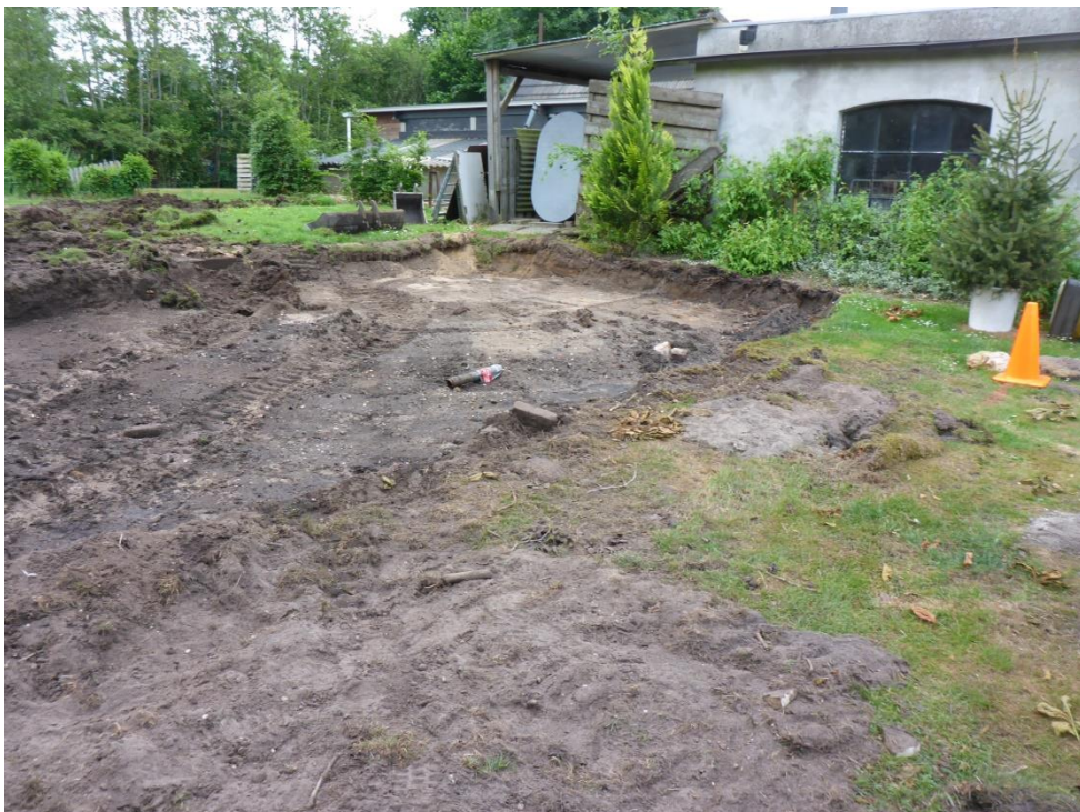
foto 14: P1050861.JPG: Ontgraven toplaag.
