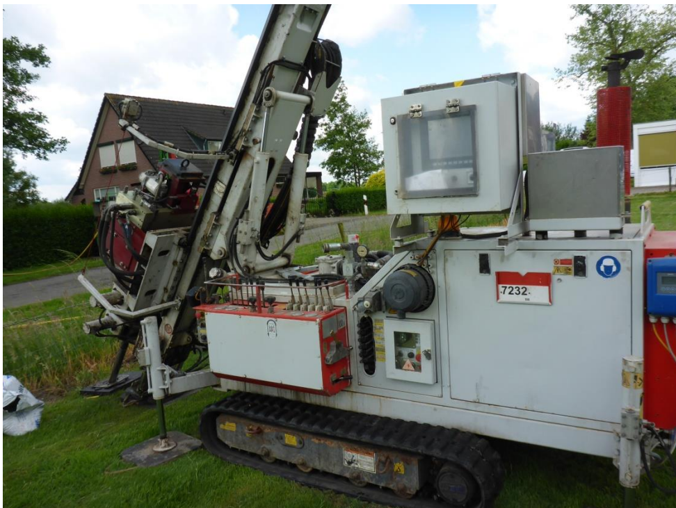
foto 12: P1050913.JPG: Uitvoering directe injectie met sonic drill t.p.v. bron 5.
