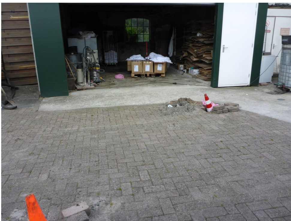
foto 16: P1060020.JPG: Klinkers verwijderd en in pandig (voormalige stomerij) betonboringen verricht voor injectie bron 1.
