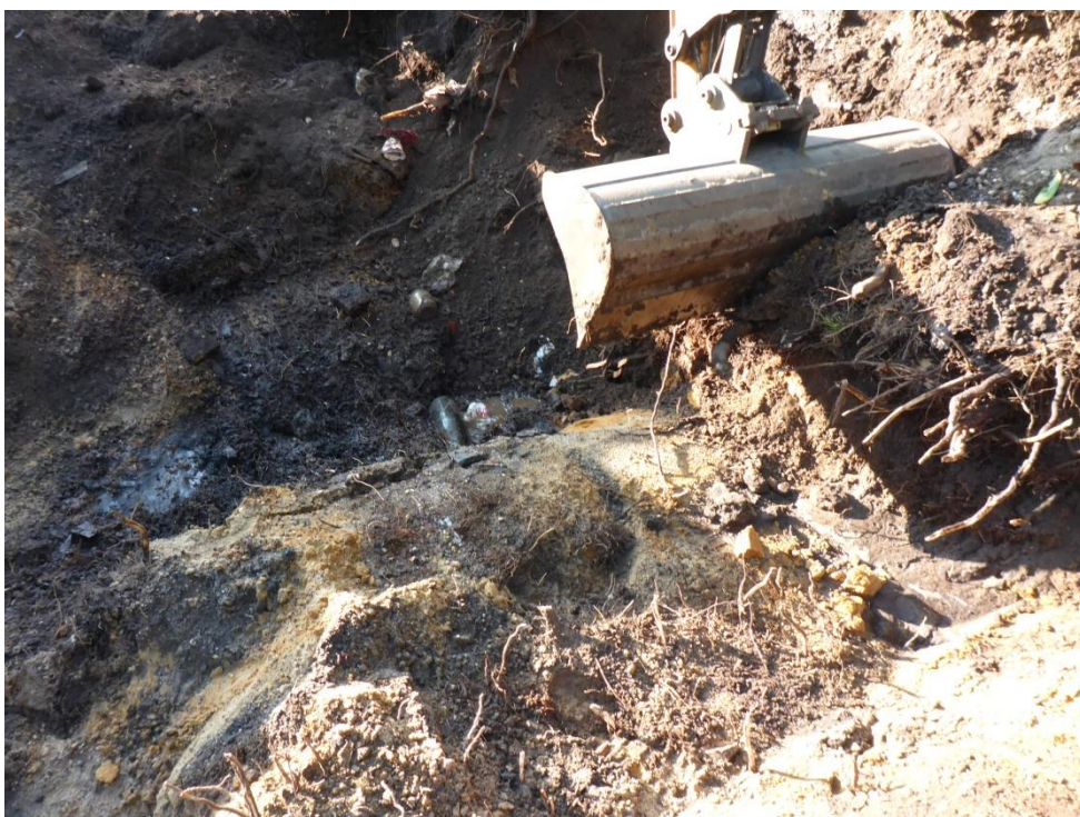
foto 17: P1050884.JPG: Voormalige greppel aangetroffen, waar de verontreinigde laag wat dieper zit .....
