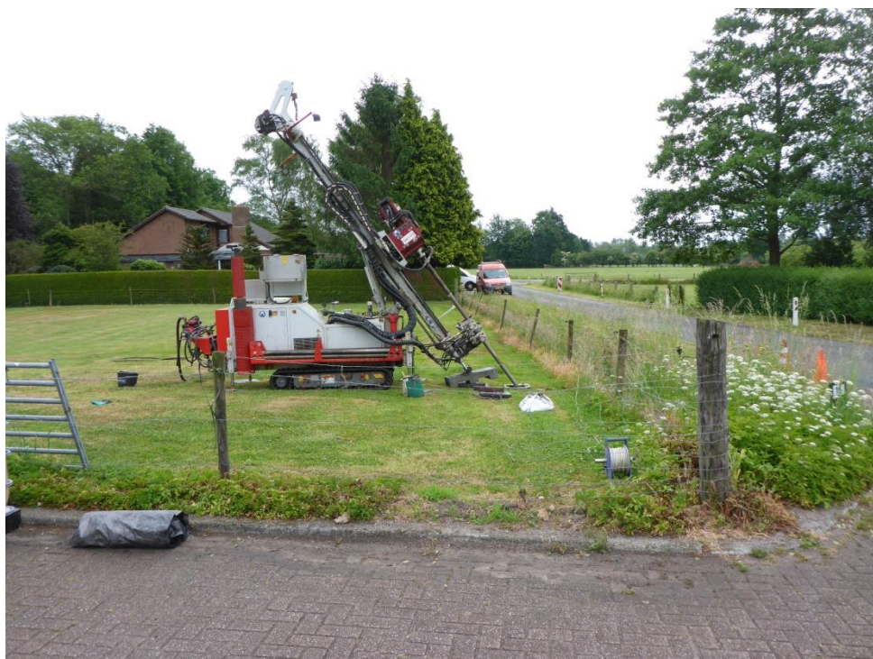
foto 14: P1050973.JPG: Uitvoering directe injectie met sonic drill t.p.v. bron 5. Injecties bron 5 vanuit weiland onder een hoek uitgevoerd om onder de wegberm uit te komen. Vanwege (water)leiding(en) in de berm was injectie in de wegberm zelf niet mogelijk.
