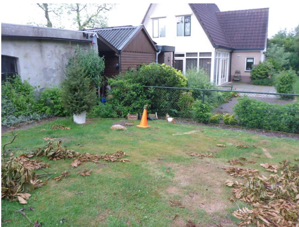
foto 1: P1050783.JPG: Overzicht voor start ontgraving.
