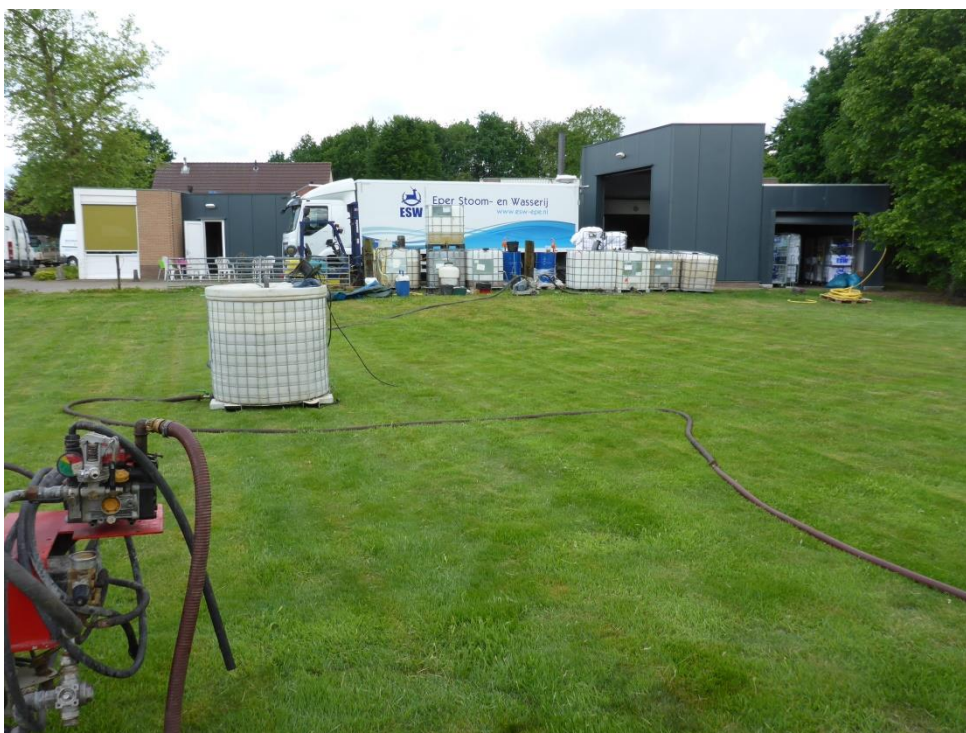
foto 9: P1050914.JPG: Aanvoer injectievloeistof.
