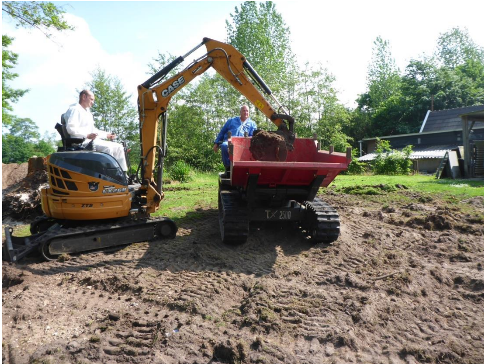
foto 13: P1050856.JPG: Werk uitgevoerd met midi-materieel i.v.m. beperking transportroute door carport.
