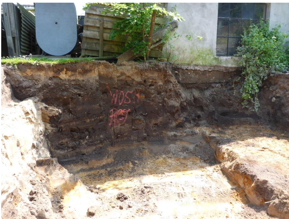
foto 41: P1050966.JPG: Eindresultaat opschoonactie W05, civieltechnisch maximale grens bereikt.
