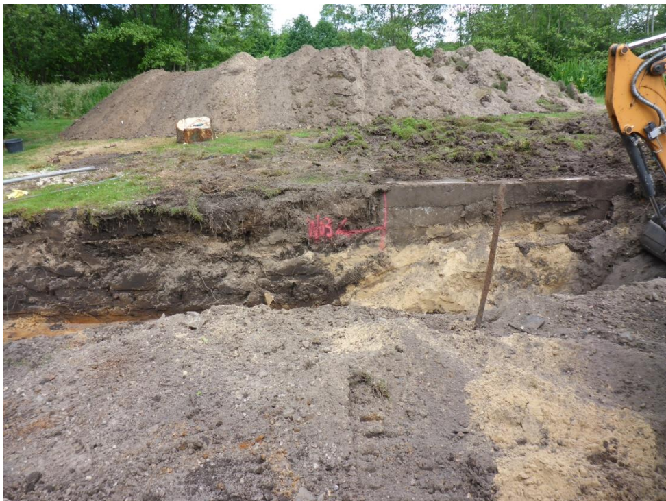
foto 26: P1050919.JPG: Ook is de codering van de putwand op de putwand weergegeven: Hier de grens van W03 met W04 (beton). Op de achtergrond het depot van de toplaag depot T01.
