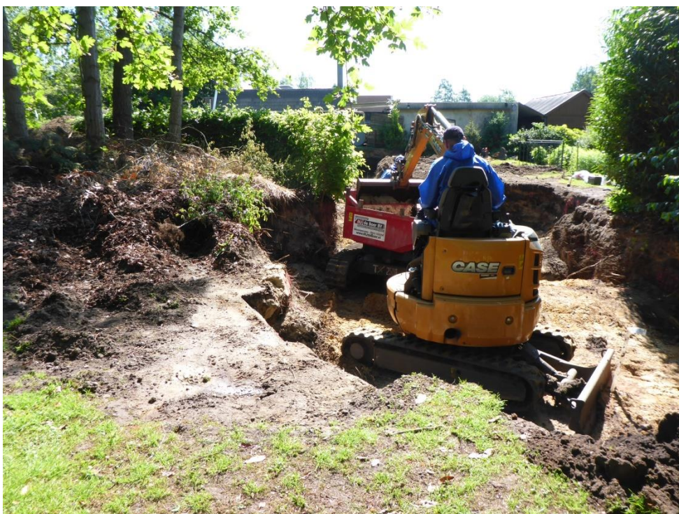
foto 29: P1050937.JPG: Eerste opschoonactie wanddeel W01.
