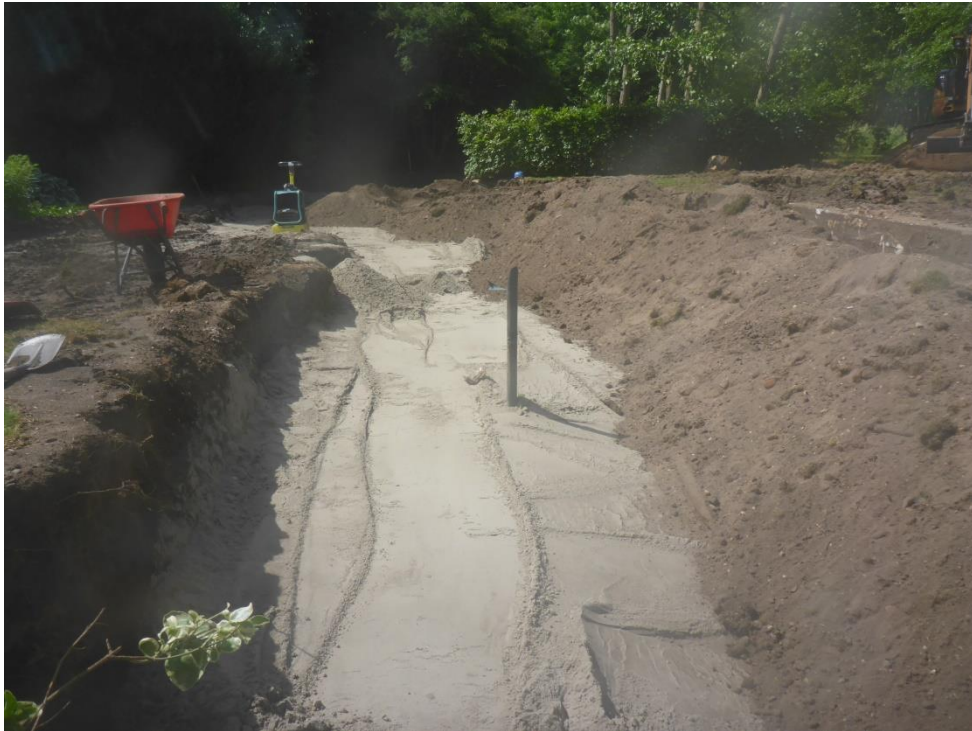
foto 49: P1060005.JPG: Bij aanvullen toplaag is ook de grond uit depot T01 hergebruikt.
