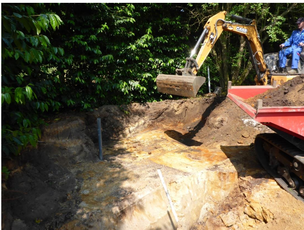
foto 39: P1050962.JPG: Tweede opschoonactie wanddeel W01 o.b.v. resultaat W01H.
