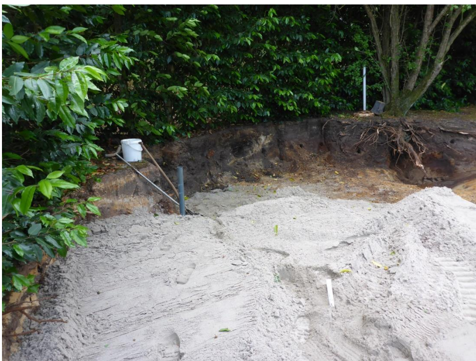
foto 45: P1050999.JPG: Eindresultaat derde opschoonactie wanddeel W01 o.b.v. resultaat W01H2. Op 6-6-'17 nog niet aangevuld in afwachting van resultaat analyse W01H3.
