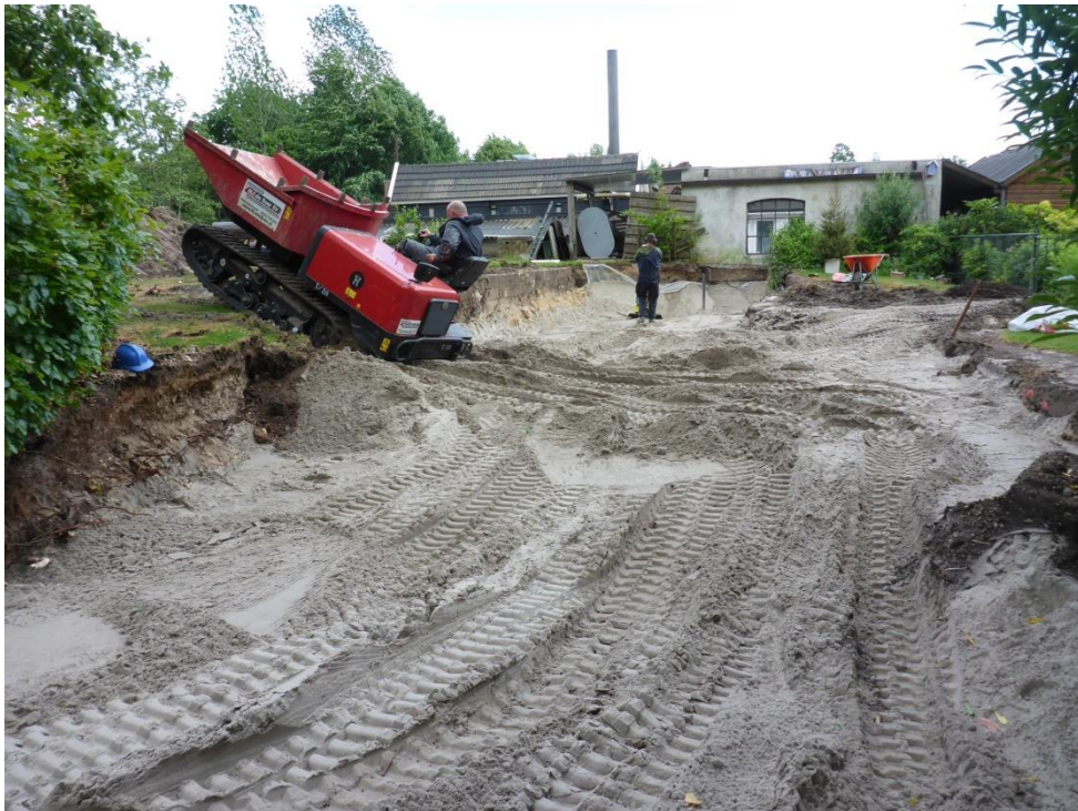
foto 48: P1060004.JPG: Aanvullen in uitvoering.
