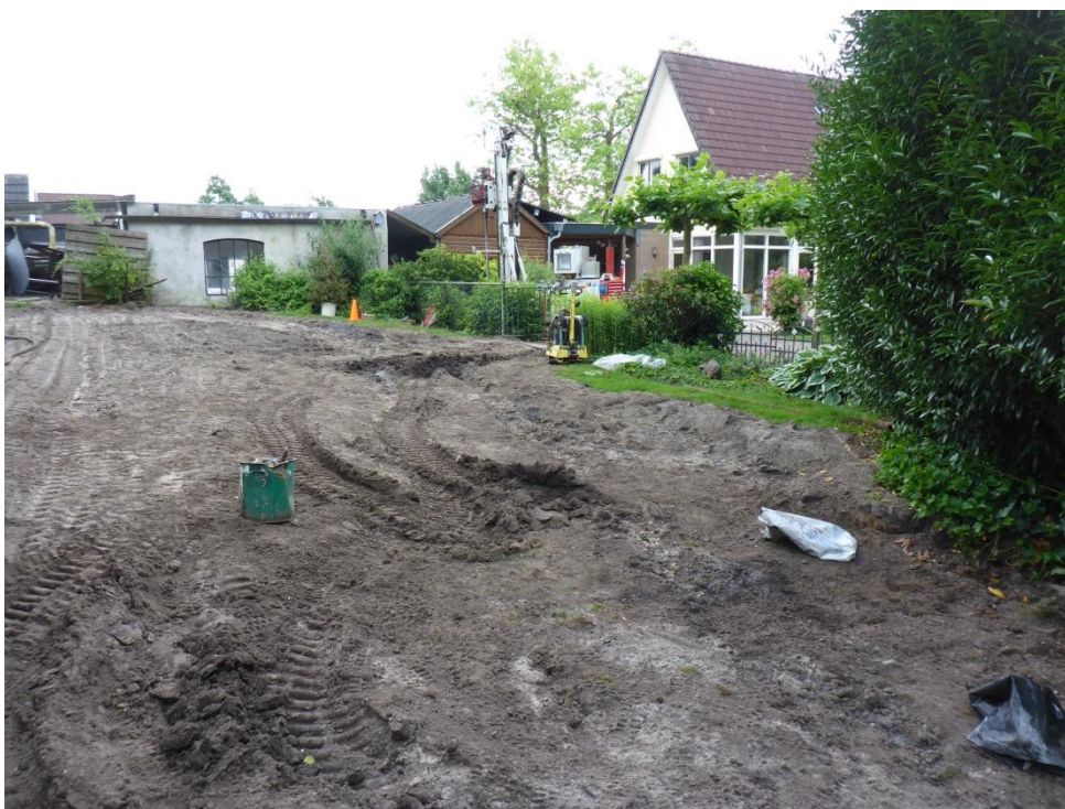
foto 54: P1060037.JPG: Eindsituatie overzicht. Op achtergrond: directe injecties in uitvoering.
