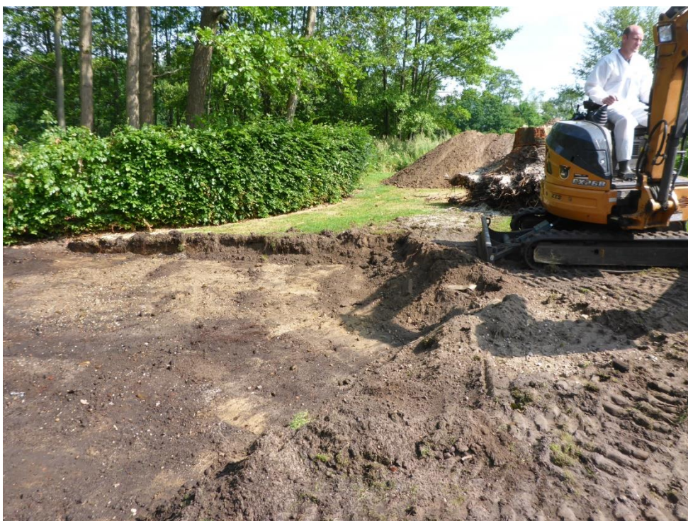
foto 12: P1050855.JPG: Ontgraven toplaag en (zie achtergrond) opslag in depot T01.
