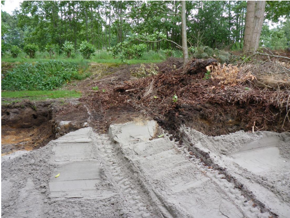
foto 47: P1060003.JPG: Aanvullen in uitvoering.
