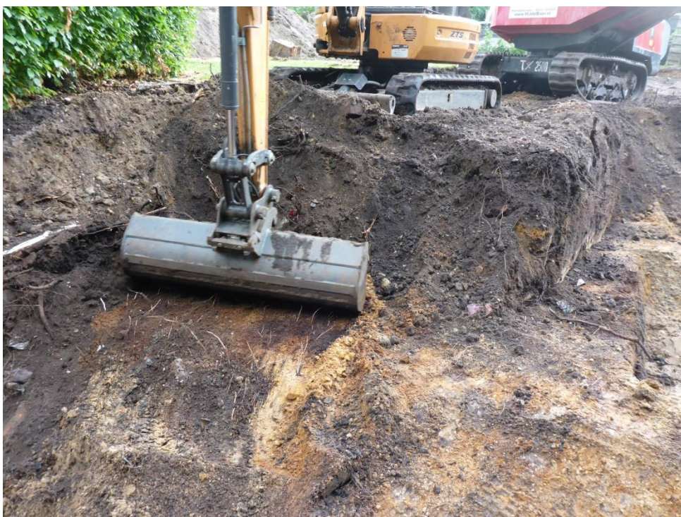
foto 21: P1050894.JPG: Voortzetting ontgraving.
