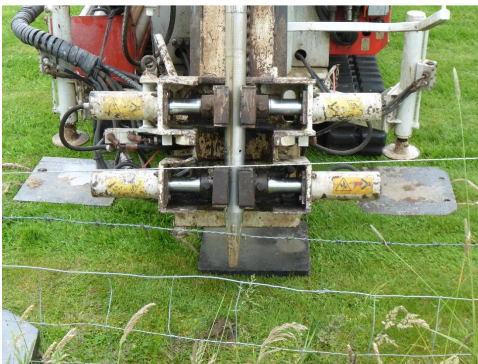
foto 10: P1050864.JPG: Uitvoering directe injectie met sonic drill t.p.v. bron 5.
