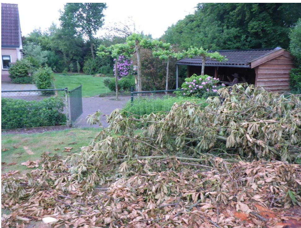
foto 2: P1050784.JPG: Overzicht voor start ontgraving.
