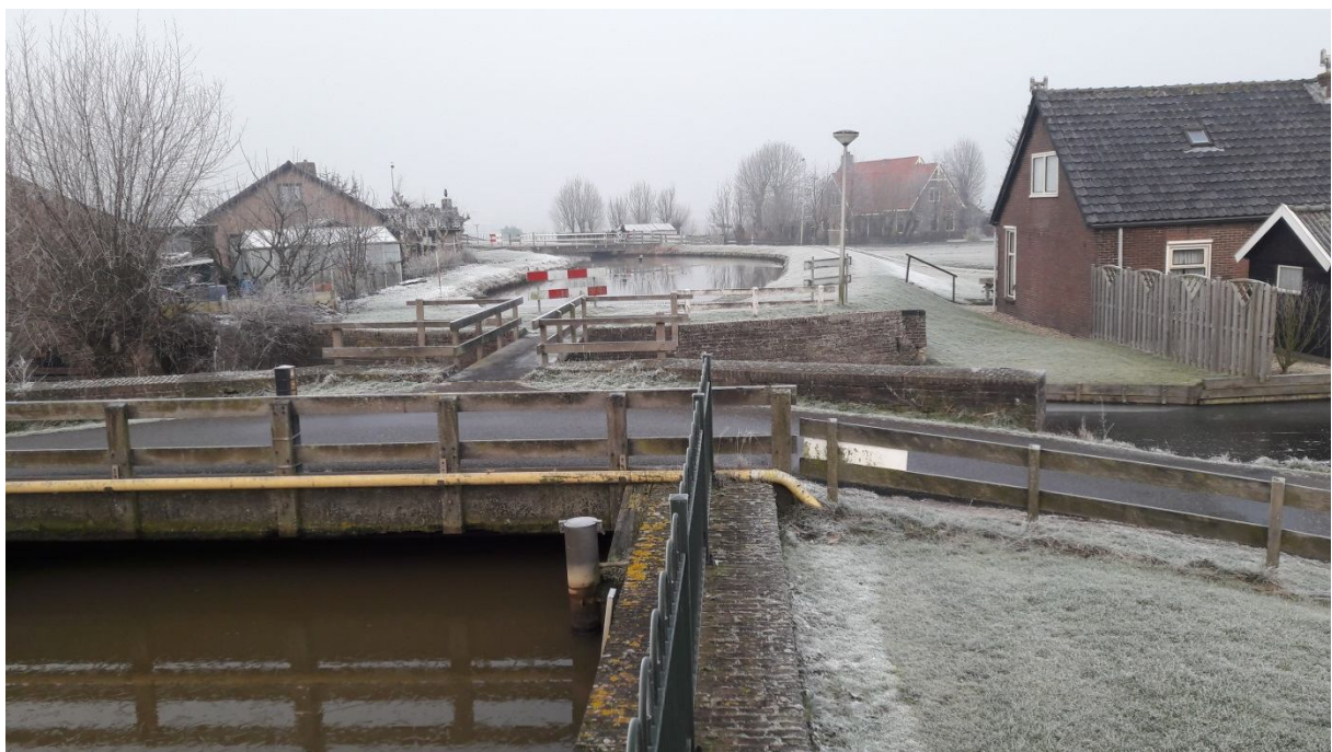
Foto d.d. 23 januari 2017, genomen bij uitstroomkanaal gemaal
