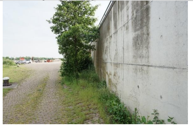
Waterkering langs het weerdplateau
