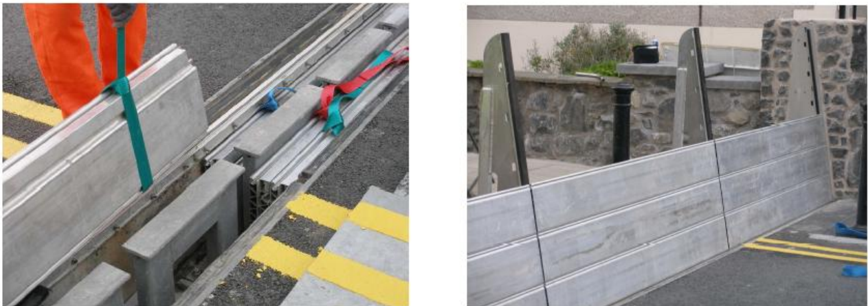
Figuur 9: Impressie demontabele kering die op locatie opgeslagen ligt - Dutchdam Cento.
