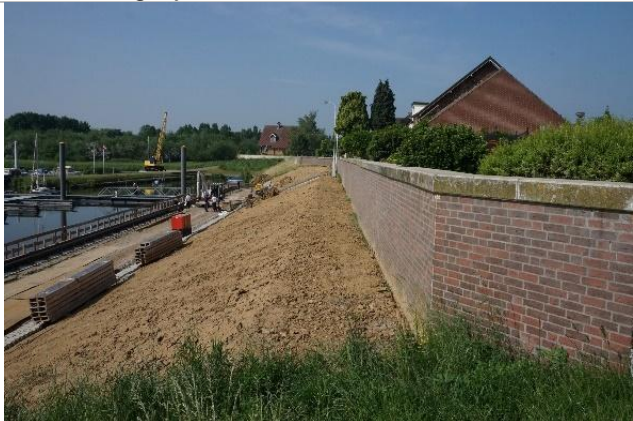
Waterkering langs de haven en woningen
