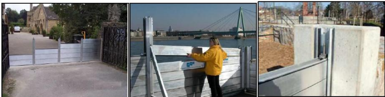
Figuur 8: impressie demontabele kering die elders opgeslagen ligt
